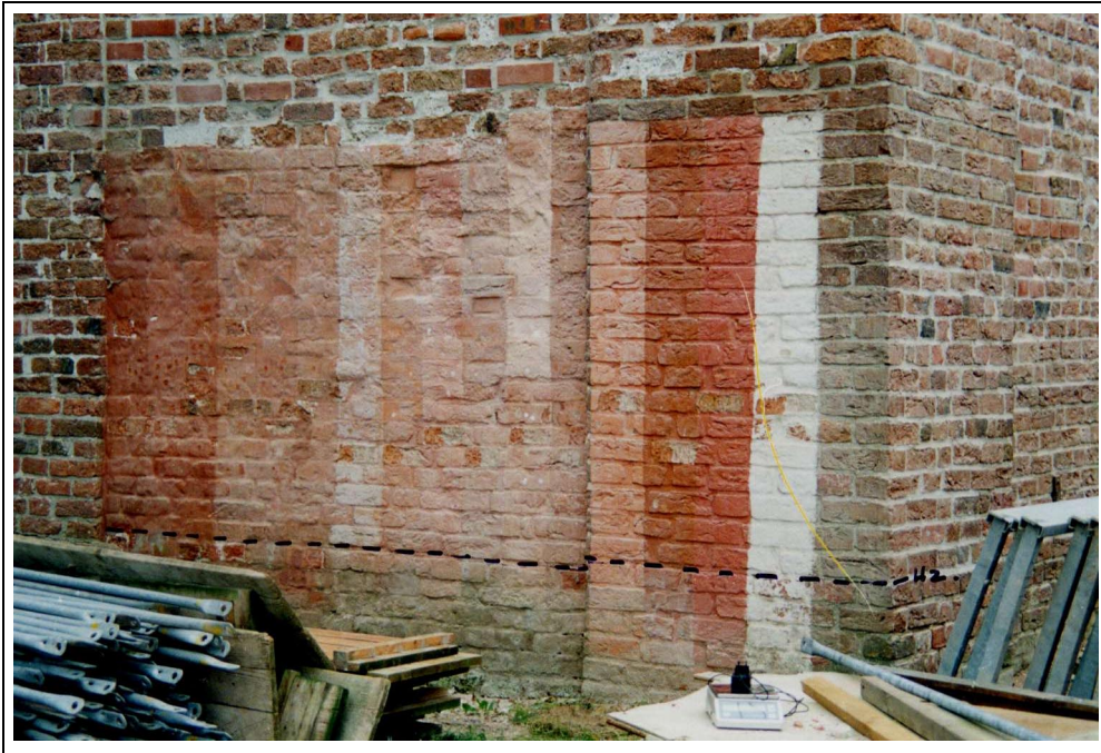
Abb. 8: Ansicht der Schlämmentestfläche an der Ostwand der ev. ref. Kirche in Eilsam nach 2½ Jahren Standzeit.
