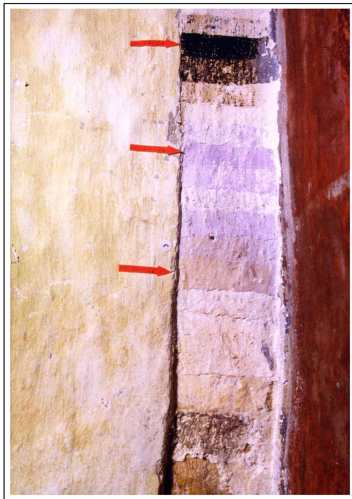
Abb. 36: Ansicht des freigelegten stratigrafischen Fensters an der Südwand der Kirche in Campen.
