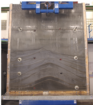
(a) ausgeschaltetes Bauteil
