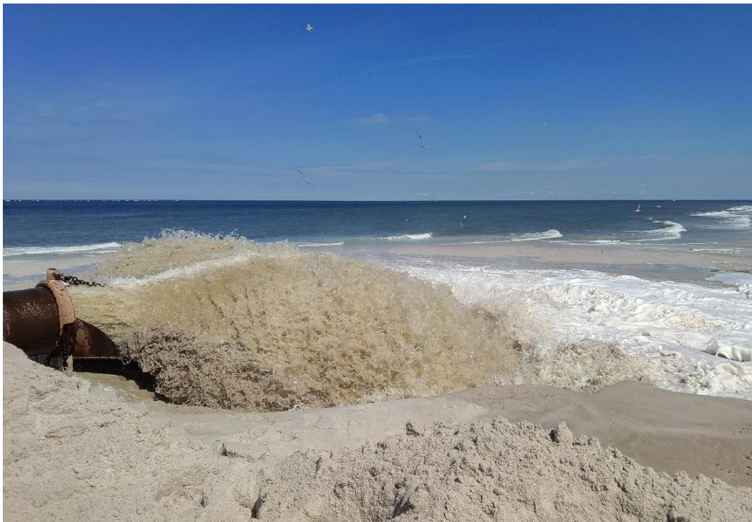
Strandaufspülung per Rohrleitung auf Sylt (Foto: C. Krautwald)
