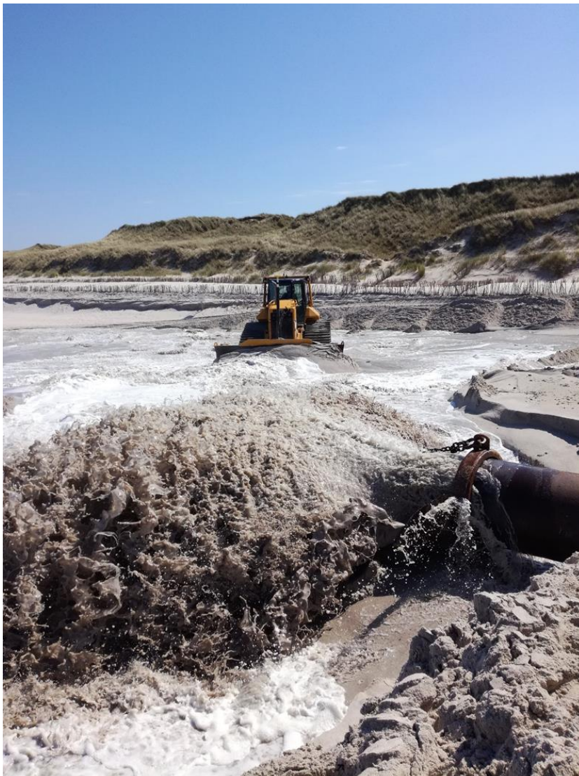
Strandaufspülung per Rohrleitung auf Sylt (Foto: R. Gieschen)
