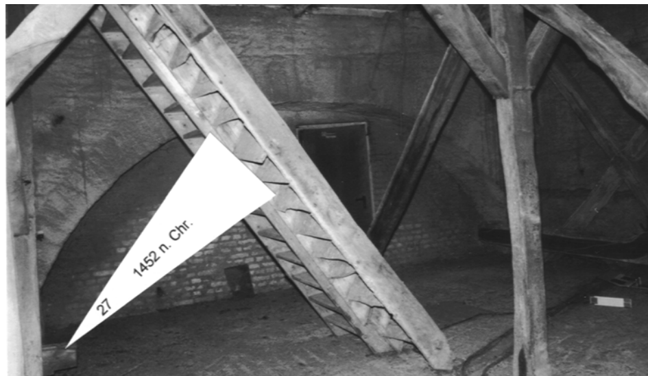
St. Kilian: Mittelbach des Turmwerks, 3. Geschoss, Blick nach Osten
