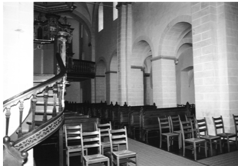
Abbildung 69: St. Kilian, Höxter, Blick nach Nordwest gegen nördliche Mittelschiffswand und Empore. – Verf.
