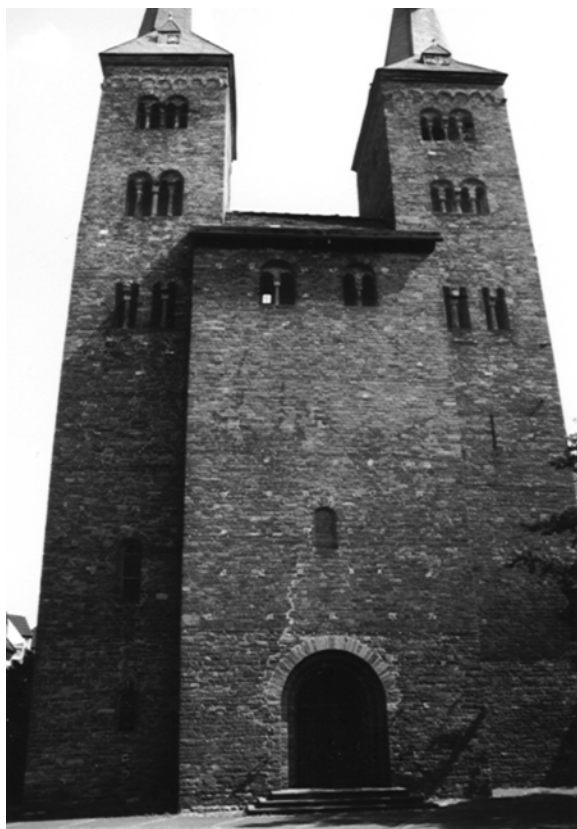
Abbildung 56: St. Kilian, Höxter, Ansicht von Westen. Knickende Fluchtlinien der Türme zwischen 4. Und 5. Turmgeschoss. – Verf.
