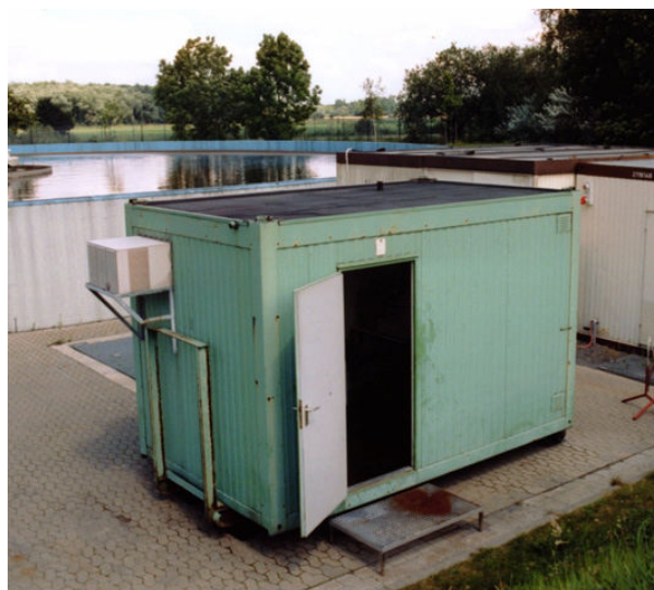
Abbildung 8: Container für den on-site Betrieb
