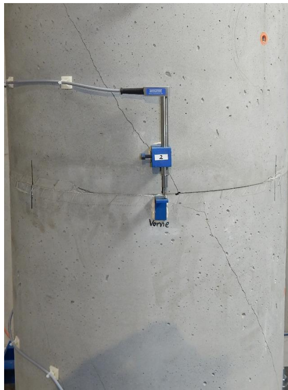
Abbildung 6-12: Torsionsrissbildungen im Stahlbetonsegment
