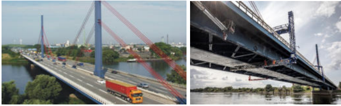
Abbildung 1: Norderelbbrücke (links: Perspektive, rechts: Untersicht während einer Bauwerksprüfung)
