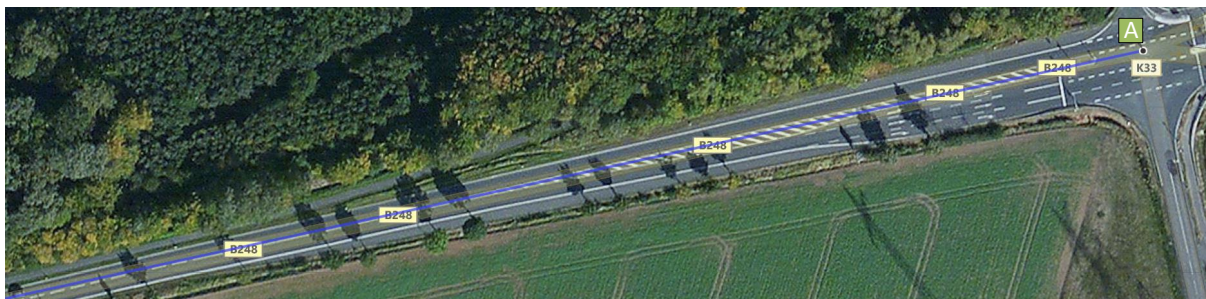
Abbildung D.5: Streckenabschnitt beim Beginn (Hinfahrt) und beim Ende (Rückfahrt) der Versuchsstrecke, Luftbild aus [257]
