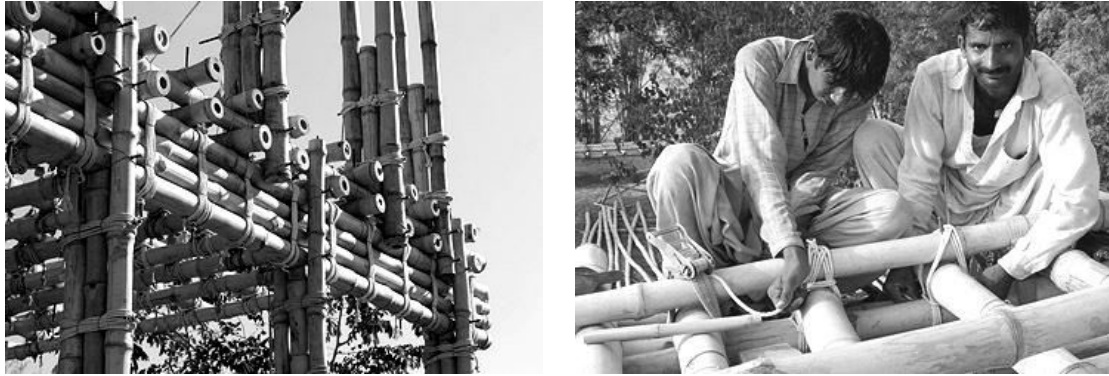
Abb. 1: Arbeiten am Schulbau Tipu Sultan Merkez in Pakistan 2012 (Ziegert-Roswag-Seiler Architekten, Berlin).
