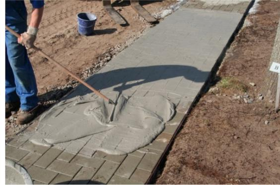
**Abb. 14:** Verfugen der gebundenen Bauweise mit Fugenmörtel (Datum: 18.04.2011)
