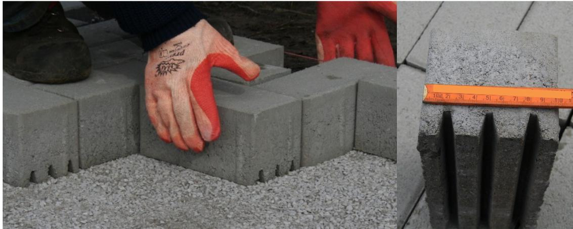
**Abb. 10:** Verlegen des Betonsteins mit profilierter Unterseite (Variante 3) zur Verzahnung der Pflasterdecke mit der Bettungsschicht (links). Unterseite des profilierten Betonpflastersteins (rechts).
