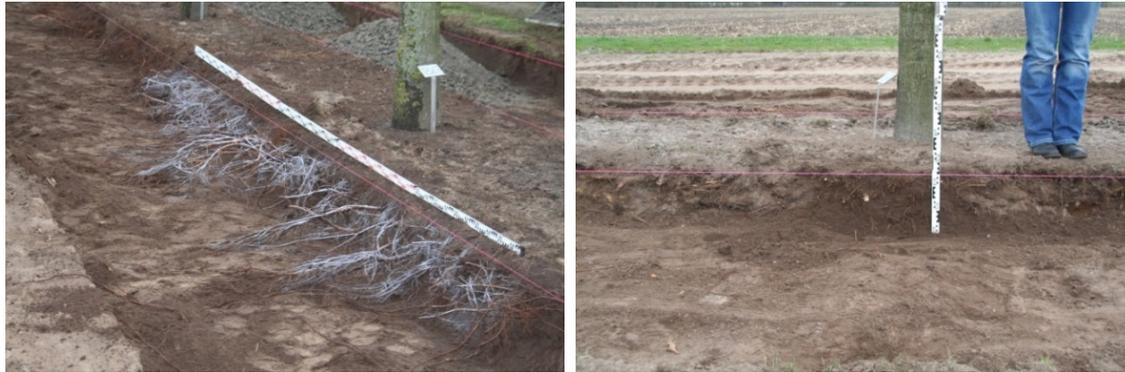
**Abb. 11:** Freigelegte Wurzeln im vorgesehenem Wegebereich, Baum 17 Südseite, Wurzeln geweißt (Datum: 06.04.2011) (vgl. STENGEL et al. 2013, S. 7) **Abb. 12:** Abgeschnittene Wurzeln vor Einbau der Tragschicht; Baum 17 Nordseite (Datum: 05.04.2011)
