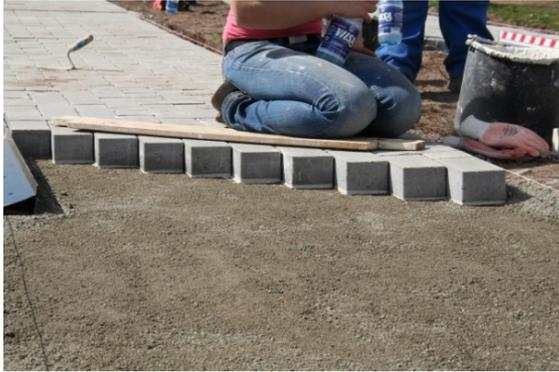
**Abb. 13:** Verlegen des Betonrechtecksteins mit aufgetragener Haftschlämme auf der Steinunterseite auf die gebundene Bettungsschicht (Datum: 14.04.2011)
