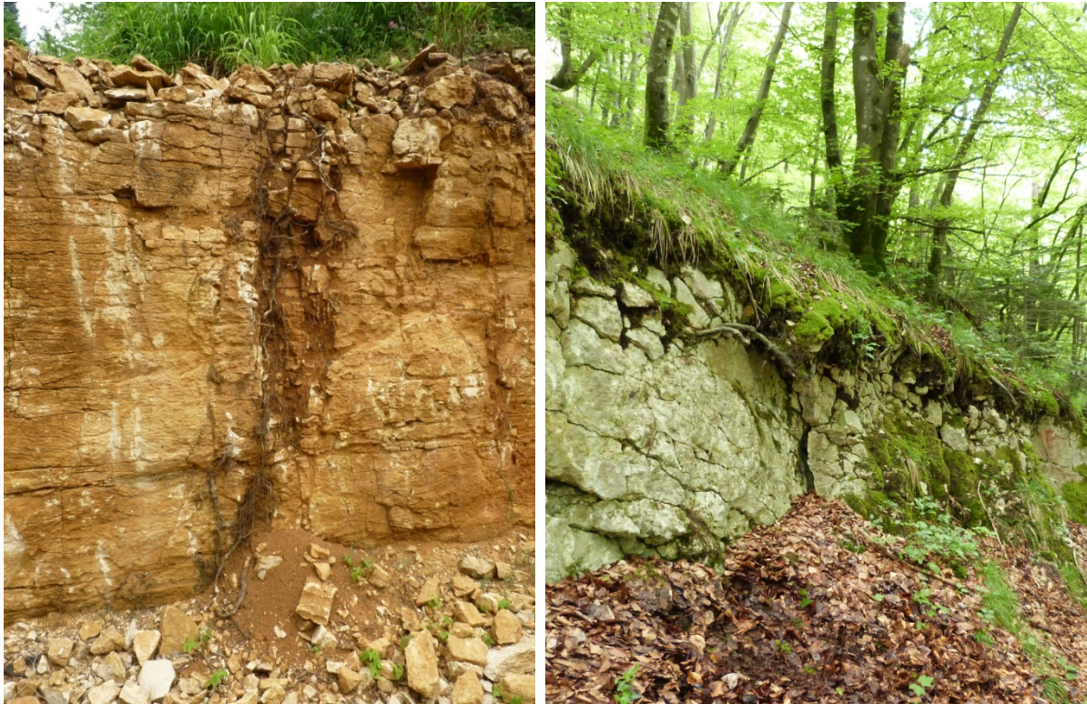
Abb. 11: Beispiele für die Durchwurzelung von Kalkgesteinen aus dem Untersuchungsgebiet. Foto links: Standort auf einem Plateau bei Rünenberg (Tafeljura). Foto rechts: Standort an einem Weganschnitt bei Dittingen (Faltenjura).
