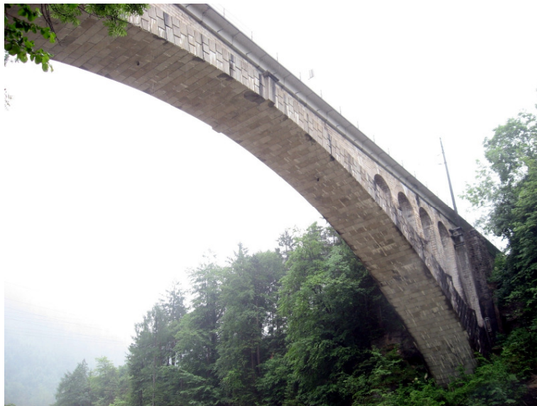
Abbildung 110: Eingleisige Mauerwerksgewölbebrücke mit offenen Stirnmauern (Beispielbrücke 2)
