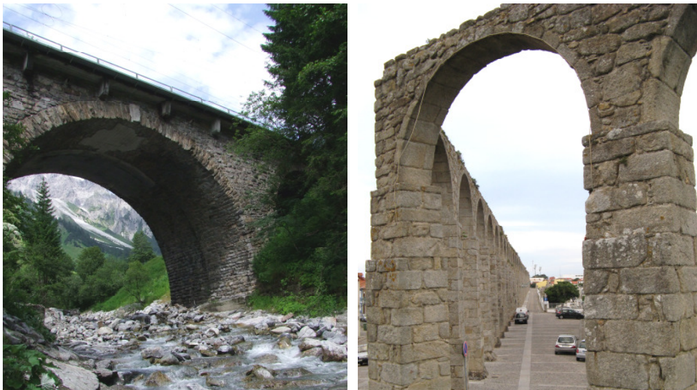
Abbildung 23: Beispiel für eine Gewölbebrücke mit kleinformatischen Steinen (links) und für ein Viadukt mit großen blockartigen Steinen (rechts)
