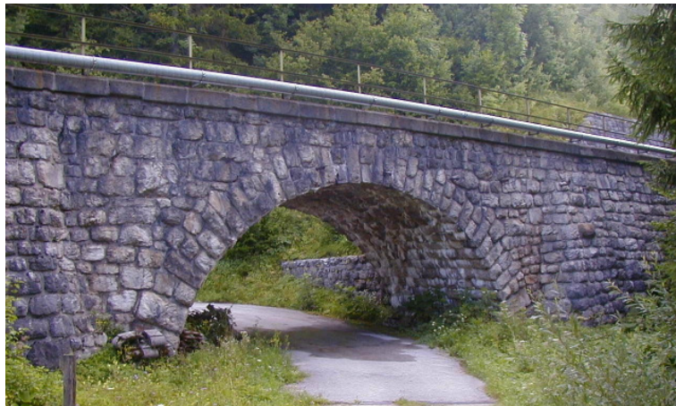
Abbildung 36: Ansicht des gewölbten Durchlasses
