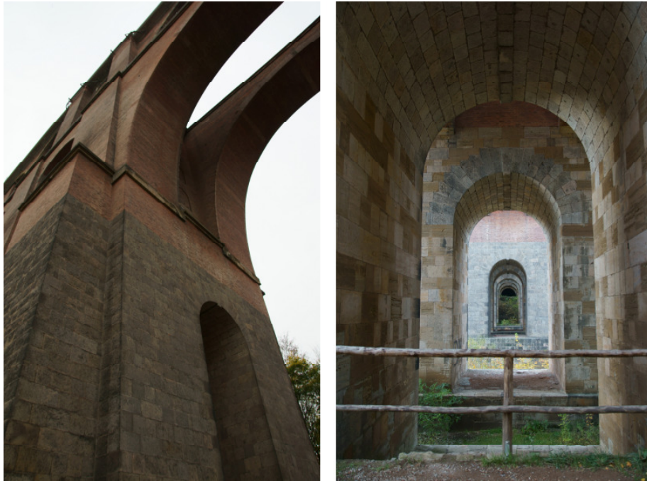
Abbildung 7: Beispiel für Spargewölbe in Querrichtung (Göltzschtalbrücke)
