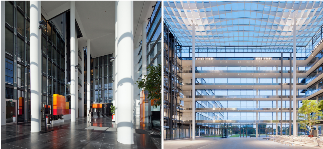
Abbildung 22: Stahlstützen in den Atrien von Skygarden (links, © CA Immobilien) und der HDI-Zentrale (rechts, © Esch) mit freundlichen Genehmigungen der Rechteinhaber
