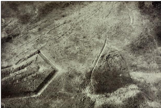
Abb. 5.1-1: Luftbildaufnahme des zerstörten Forts Douaumont bei Verdun (Frankreich) mit Schützengräben, Annäherungswegen und Kampfstellungen (undatiert).
