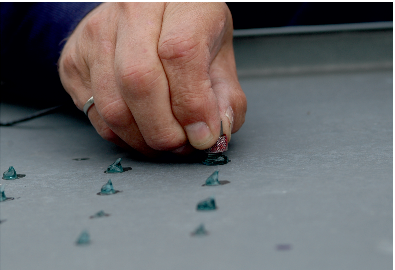
Abbildung 29: Messort nach Aufbringen des Koppelmittels auf die Titanzinkdeckung, Beginn der Messung: Andrücken des Prüfkopfs auf den ersten Messpunkt des Messortes.
