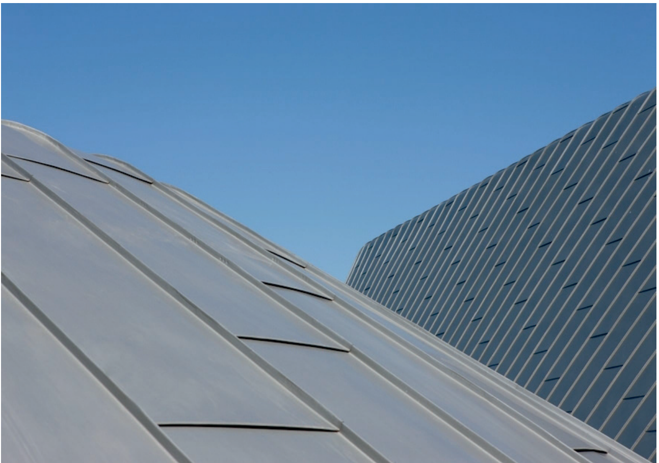
Abbildung 64: Stehfalzdeckung - Ansicht einer Dachlandschaft. © Rheinzink.
