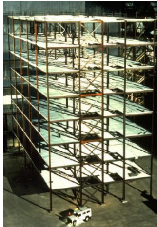
Abbildung 2.7: Versuchsgebäude in Cardington (aus Newman u. a. [87])
