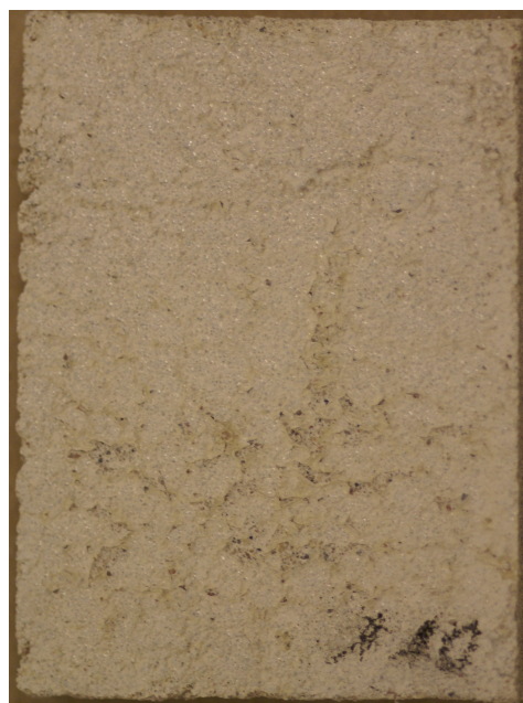
Abb. 43 Aufstehende, abrollende und abplatzen- de Caseinschicht auf einem Probekörper
