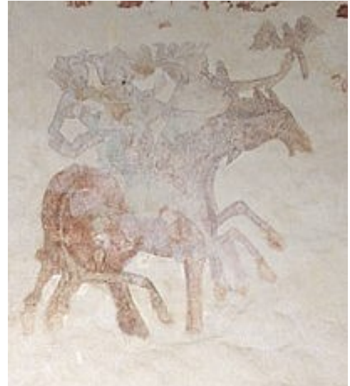
Abb. 10 Mikrobieller Befall in Form eines Weißschleiers
