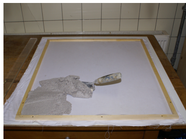
Abb. 13 Auftragen des Putzes
