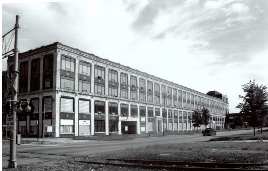
Abb. 11: Packard Assembly Plant, East Grand Boulevard, 2000, erbaut 1907 – 09, stillgelegt 1956, bis in die 90er Jahre gab es teilweise zumeist kleingewerbliche Nachnutzungen, Architekt Albert Kahn. Das denkmalgeschützte Ensemble von 47 Gebäuden gilt als die erste Fabrik in Stahlbetonbauweise. In den besten Zeiten waren hier bis zu 40.000 Menschen beschäftigt.
