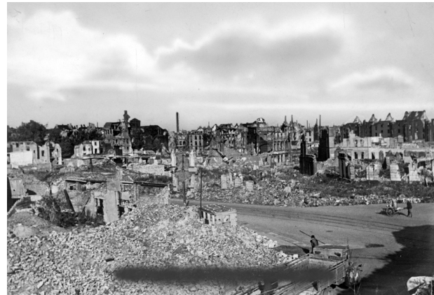
Abb. 16: Zerstörte Schützenstraße, Nordstadt 1945
