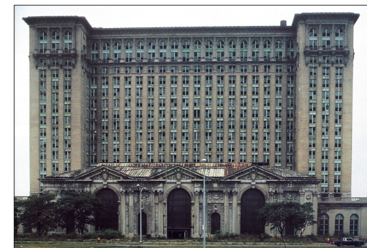
Abb. 1: Michigan Central Station Detroit, Detroit Corktown, erbaut 1910–13, endgültig stillgelegt 1988 und seither leerstehend, Architekten Warren&Wetmore/Reed&Stern (Grand Central Station, New York), Abrissbeschluss des Stadtrats in 2009, dagegen kämpft eine Bürger/inneninitiative für den Erhalt des denkmalgeschützten Gebäudes. Foto: Camilo José Vergara, StadtBauwelt Nr. 127, Sept. 1995
