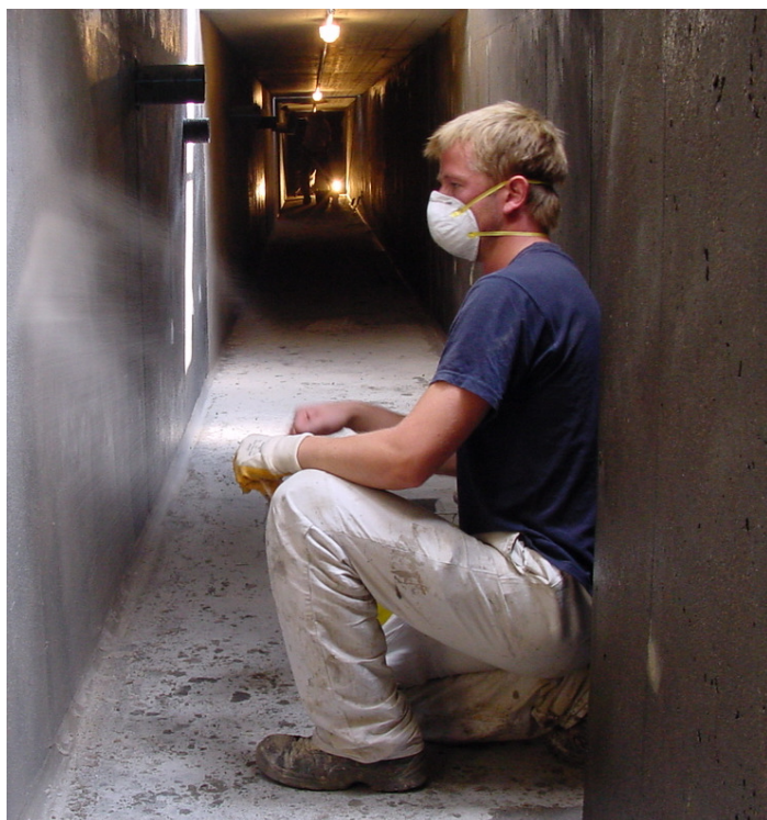
Abb. 30: Sandbewurf der grundierten Wand eines Versorgungsschachts
