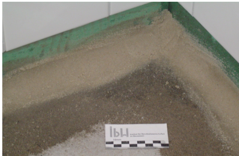
Abb. 22: Fertiggestellte Hohlkehle
