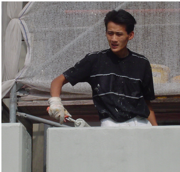
Abb. 17: Fassadenbeschichtung im Rollverfahren (Wohnkomplex)
