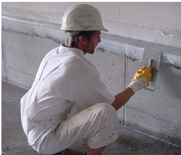
Abb. 24: Anspachteln eines Fugenbandes
