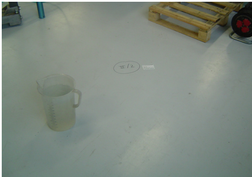
Abb. 5: Industrieboden in einer Fertigungshalle
