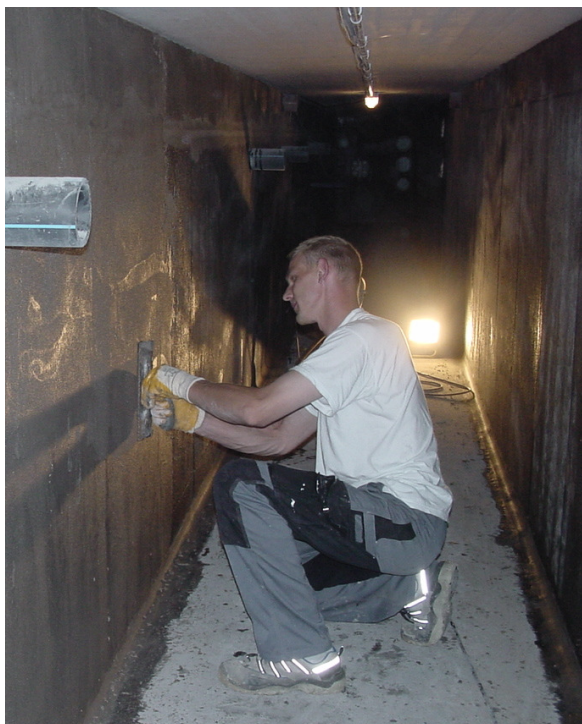
Abb. 4: Arbeiten in einem Vorsorgungskanal für Abwasserleitungen
