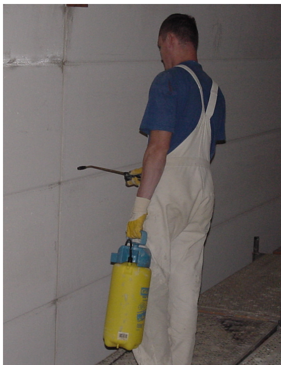
Abb. 18: Vornässen des Untergrunds
