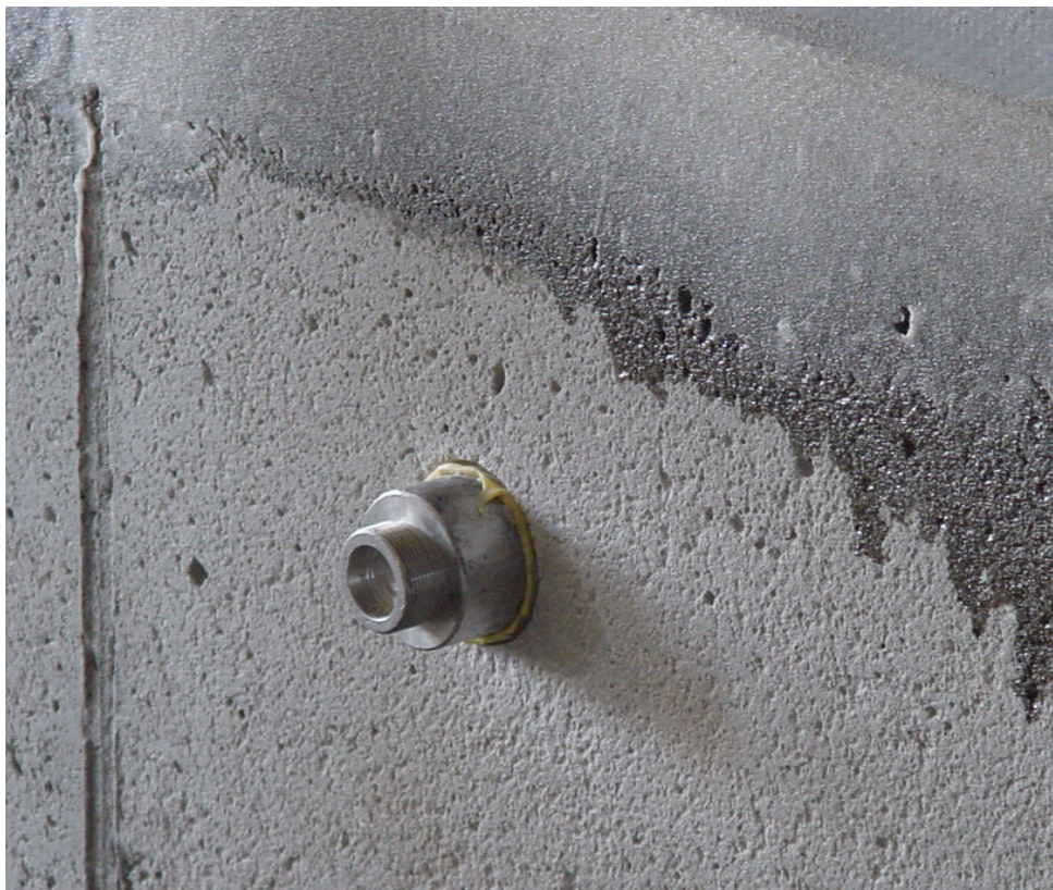
Abb. 32: Aufgeklebter Haftzugstempel vor der Prüfung
