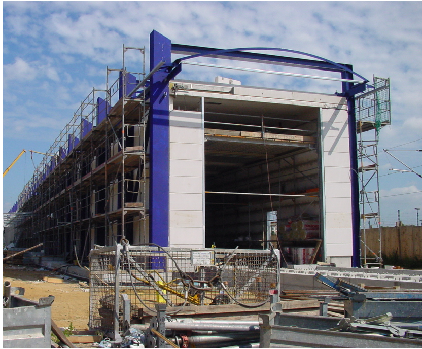
Abb. 7: Zugwaschanlage im Bauzustand
