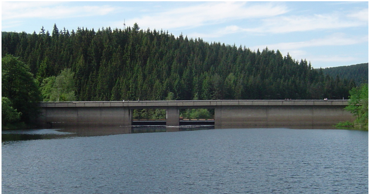
Abb. 3: Betonstaumauer einer Talsperre
