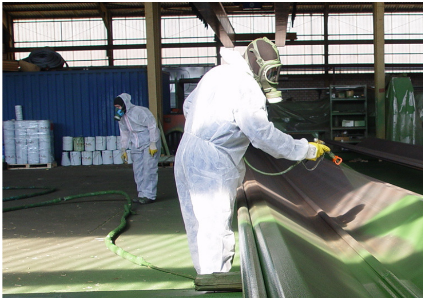
Abb. 14: Airless-Spritzen von liegenden Metallteilen (Spundwände)
