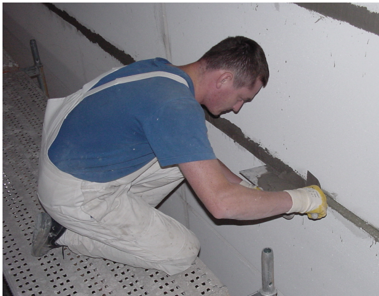
Abb. 21: Aufbringen von Mörtel mit Traufel
