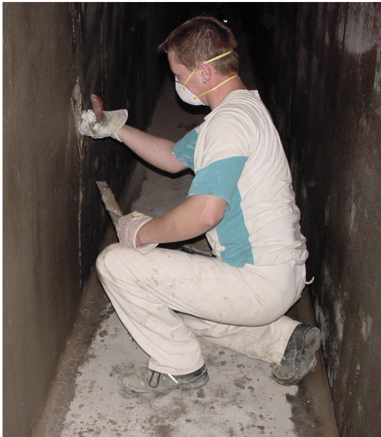
Abb. 20: Kratz- und Lunkerspachtelung mit Glättkelle
