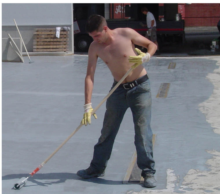
Abb. 16: Bodenbeschichtung im Rollverfahren (Parkdeck)
