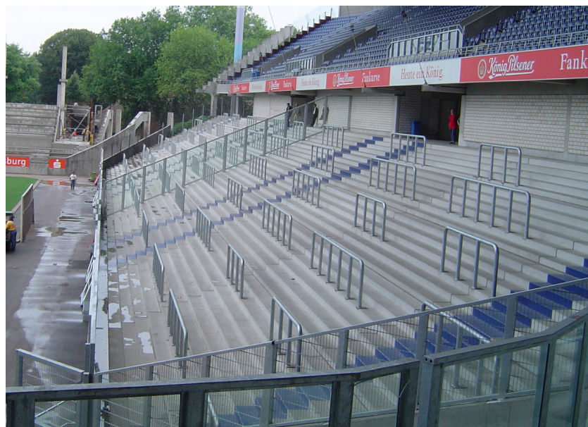
Abb. 6: Zuschauerränge aus Beton in einem Fußballstadion
