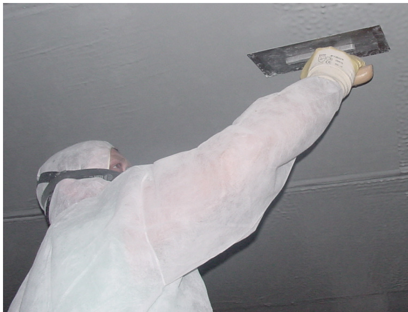
Abb. 26: Über-Kopf-Arbeiten mit Glätter
