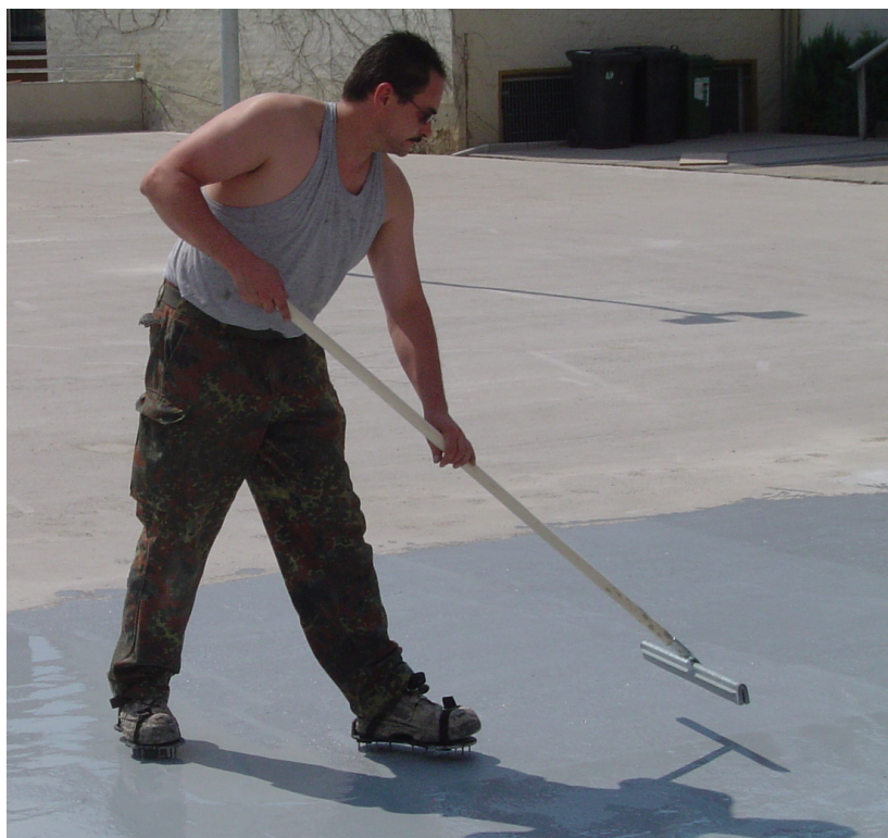
Abb.28: Beschichtung mit einer Gummirakel
