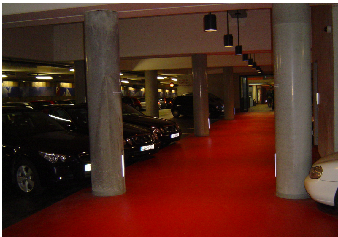
Abb. 2: Beschichtetes Parkdeck in einer Tiefgarage
