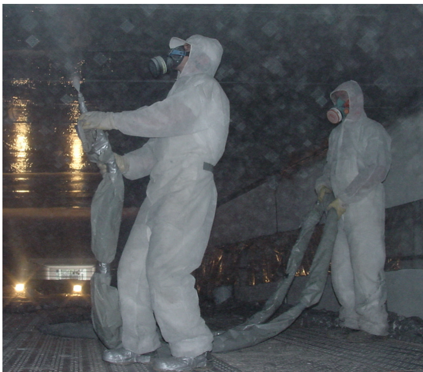
Abb. 15: Airless-Spritzen einer Betondecke (Zugwaschanlage)
