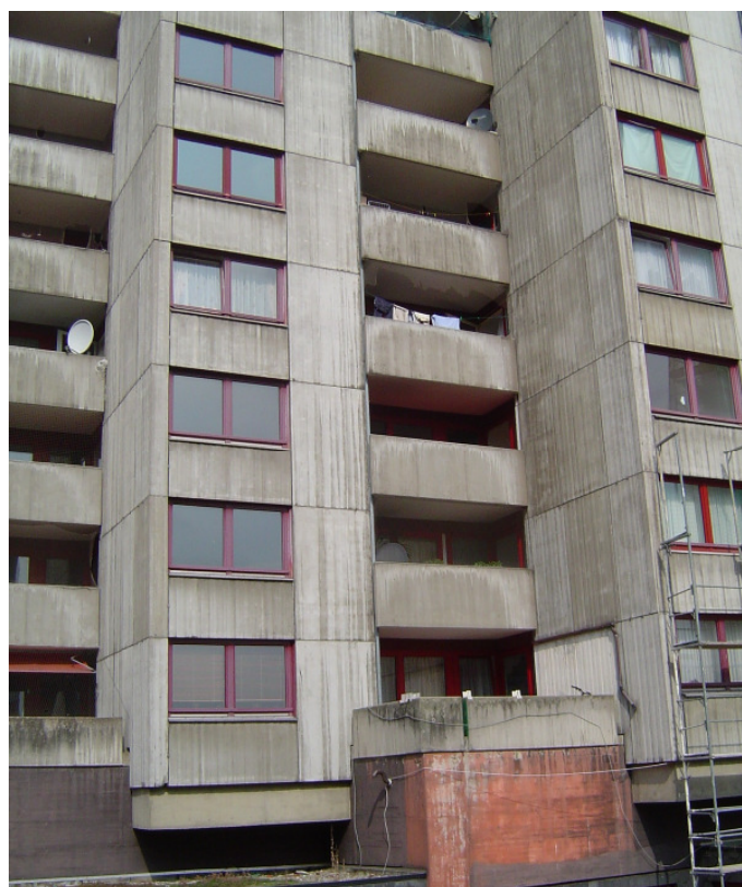
Abb. 1: Wohnblock mit Betonfassade
