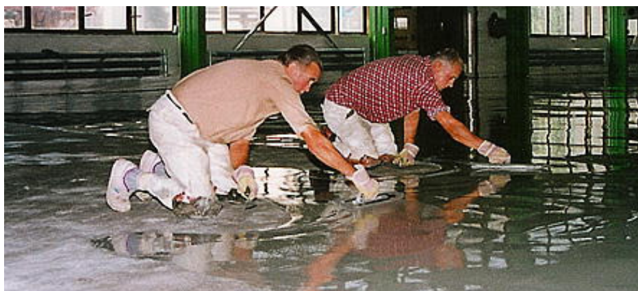
Abb. 25: Fertigung einer Deckbeschichtung mit Glätter 172
