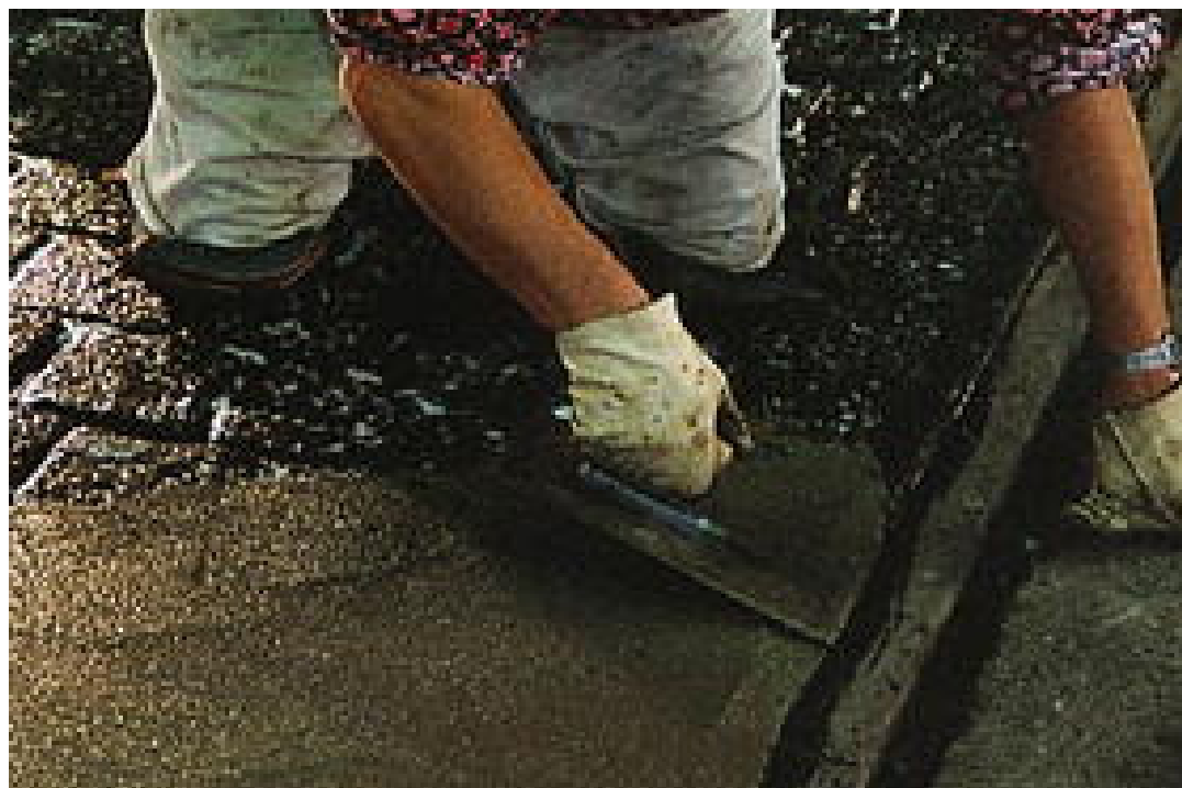
Abb. 19: Verarbeiten von Mörtel mit der Glättekelte 170
