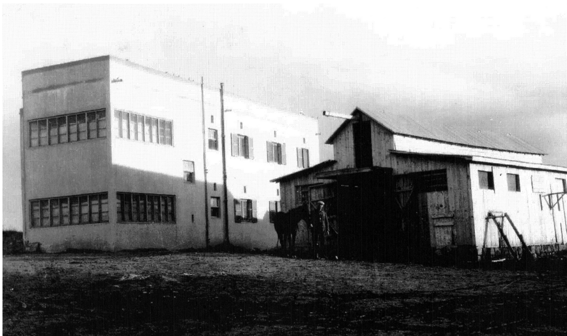
Abbildung 100: Kinderhaus, gemauert und zweigeschossig (links) von Arie Shanon neben Stallungen aus Holz (rechts) im Kibbutz Sarid, 1935
