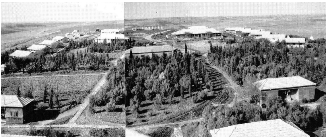
Abbildung 119: Wohnhäuser im Kibbutz Dalia, ca. 1946 Blick vom Westen
