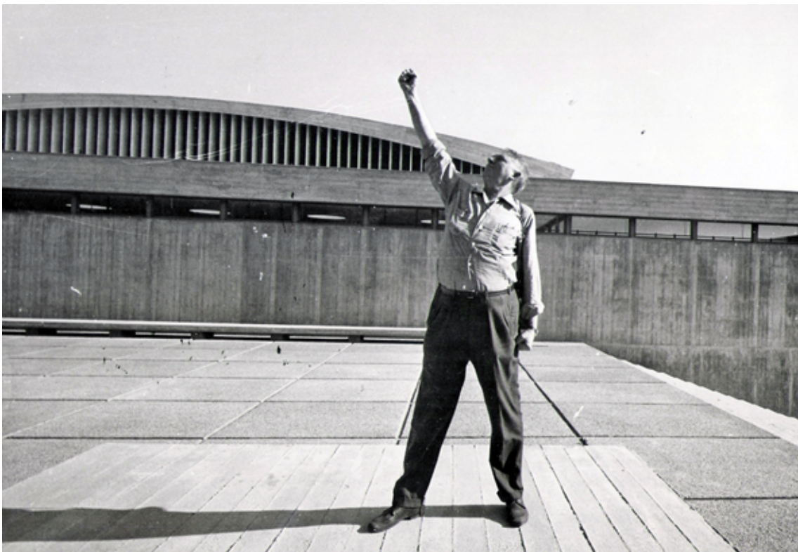
Abbildung 137: Arie Sharon auf dem Dach des Churchill Auditoriums des Technions Haifa, 1958
