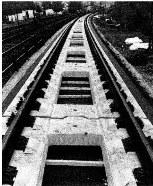
Abbildung 4-19: Betonfertigteilrahmen der Bauart FTR vor dem Spindeln [96]
