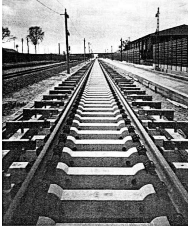
Abbildung 4-6: Bauart Rheda mit Regulierungshilfen [3]
