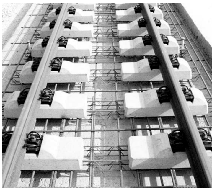
Abbildung 4-13: Ansicht der Bauart Rheda 2000 [45]
