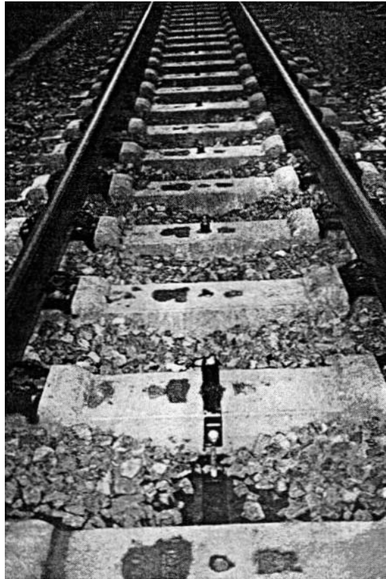
Abbildung 4-33: Ansicht der Bauart BTD, Version 1 [3]
