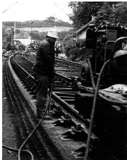
Abbildung 4-25: Bauart SATO im Bahnhof Welsede mit Herstellung der Bohrlöcher für die Nelson-Anker [96]
