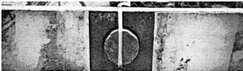
Abbildung 4-39: Detailansicht Schwellenunterseite mit Dübelstein für Bauart Getrac [3]
