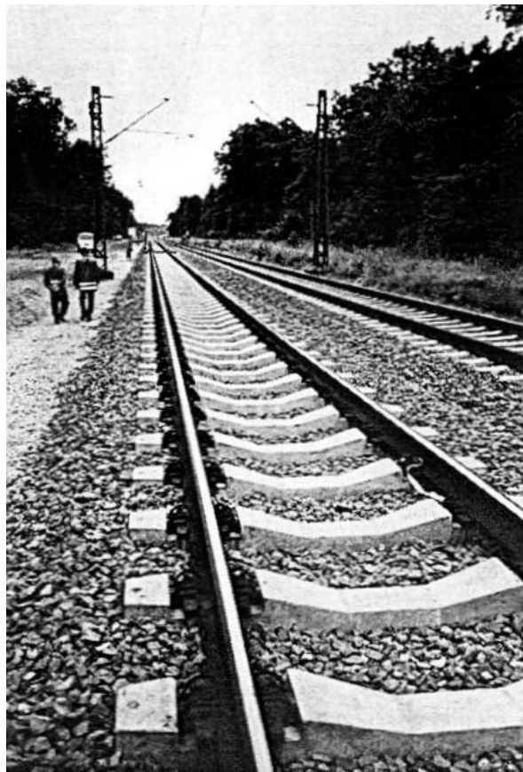
Abbildung 4-29: Ansicht der Bauart FFBS-ATS-SATO [3]
