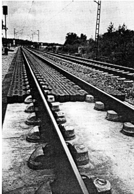
Abbildung 4-47: Ansicht der Bauart Hochtief/Schreck-Mieves/Longo [3]
