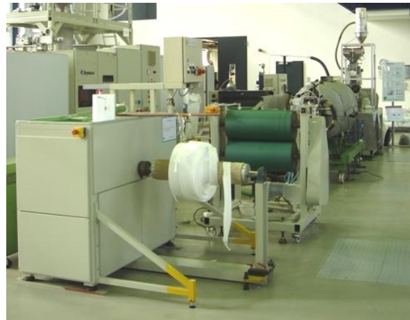
Abb. 3-4: Extrusionsanlage Physikalisches Schäumen
