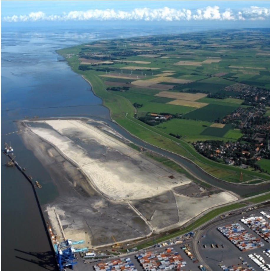
Abbildung 24: Baustelle CT IV - Juli 2005 ( www.bremenports.de )
