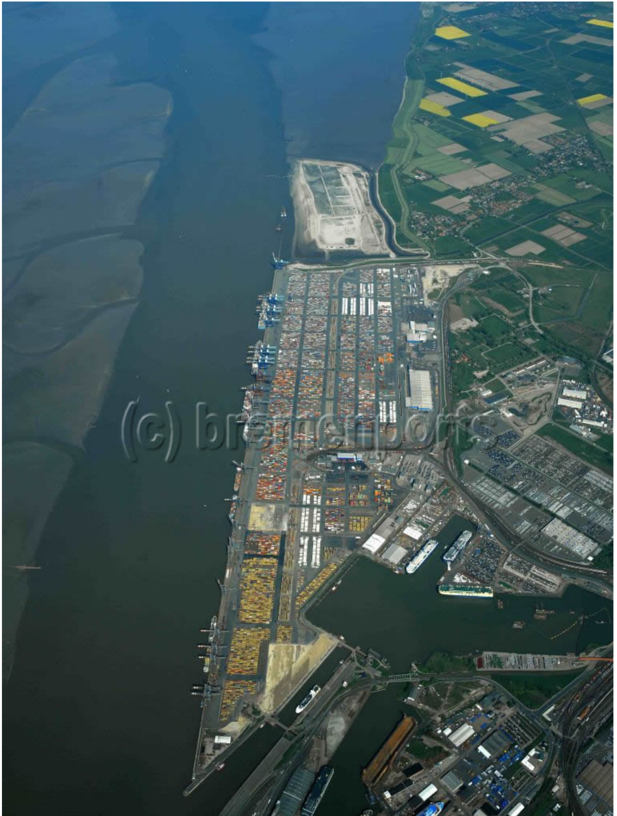
Abbildung 22: Blick auf die Hafenanlagen von Bremerhaven nach Norden, CT IV im Bau (BREMENPORTS 2008, www.bremenports.de , Einsicht 15. September 2008)
