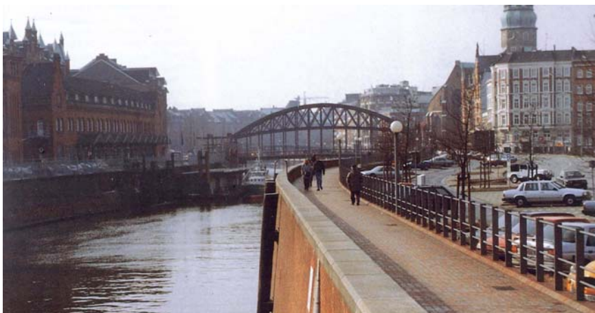
13 Kaimauer am Zollkanal, Architekt G. Talkenberg
