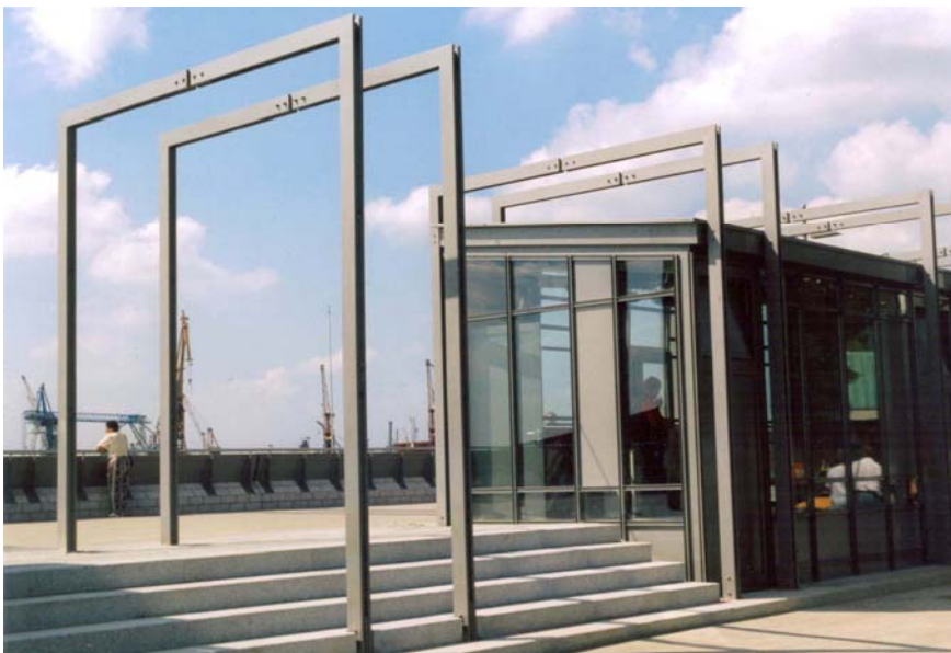
19 Pavillons, Treppenanlage und Stahlbügel als Übergangselemente zwischen Straßen- und Promenadenraum
