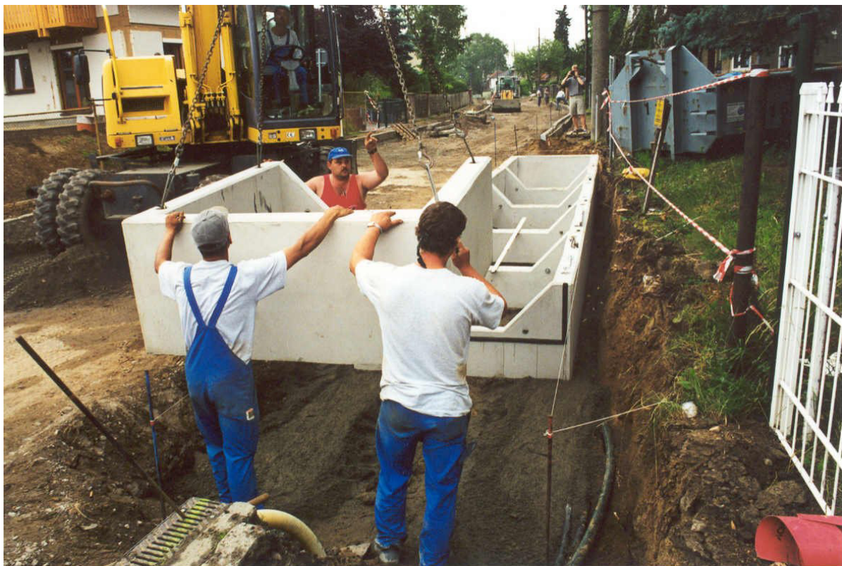
Abb. 45: Rahmenelement beim Einbau
