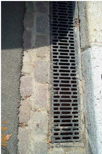
Abb. 52/Abb. 53/Abb. 54: Einbau des Entwässerungssystems INNOLET®-Rinne in Berlin, Halbinsel Stralau, Krachtstr.
