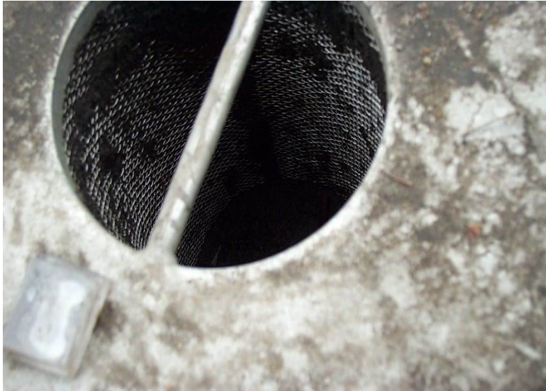
Abb. 105: Belag auf dem Edelstahlfilter
