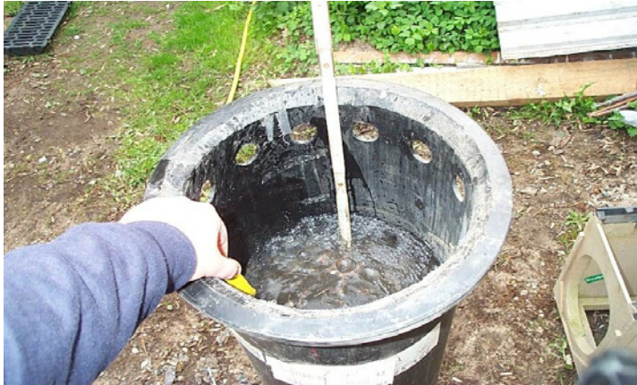
Abb. 98: Einstautest nach der Spülung
