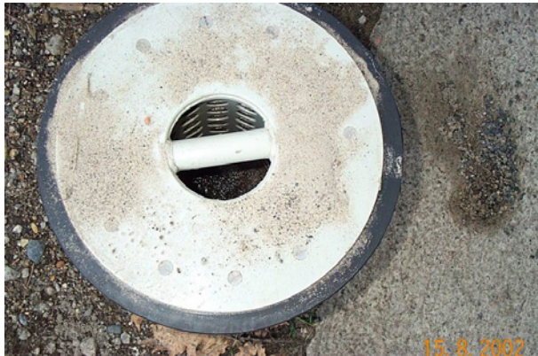
Abb. 79: Filterpatrone, nur geringe Ablagerungen auf der Filterpatrone nach Optimierung des Grobstoffrückhaltes
