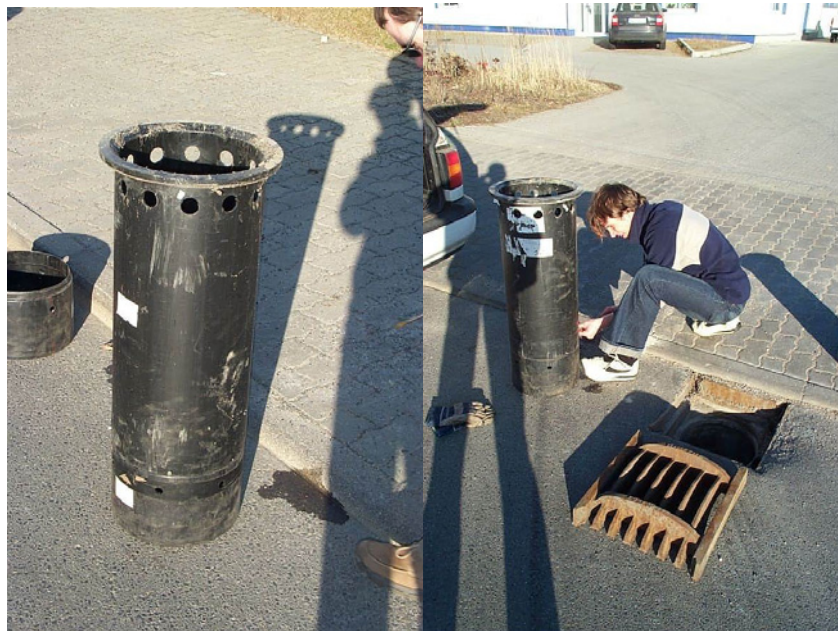
Abb. 84/Abb. 85: INNOLET®-Filterpatronen vor dem Einbau in den Straßeneinlauf
