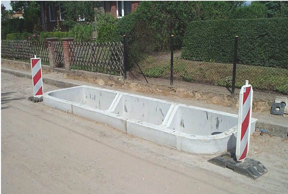
Abb. 46: Tiefbeet, bestehend aus 3 Elementen, kurz nach dem Einbau
