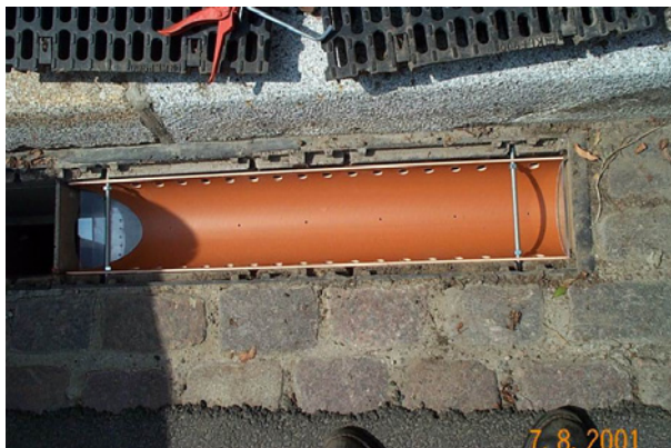
Abb. 55/Abb. 56/Abb. 57/Abb. 58: Einbauteile für INNOLET®-Rinne nach Einbau in Berlin, Halbinsel Stralau, Krachtstr.
