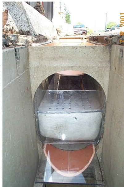
Abb. 55/Abb. 56/Abb. 57/Abb. 58: Einbauteile für INNOLET®-Rinne nach Einbau in Berlin, Halbinsel Stralau, Krachtstr.
