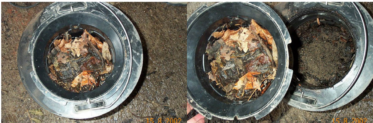
Abb. 64/Abb. 65/Abb. 66: Filterpatrone, Außenteil mit Einsatz zum Grobstoffrückhalt
