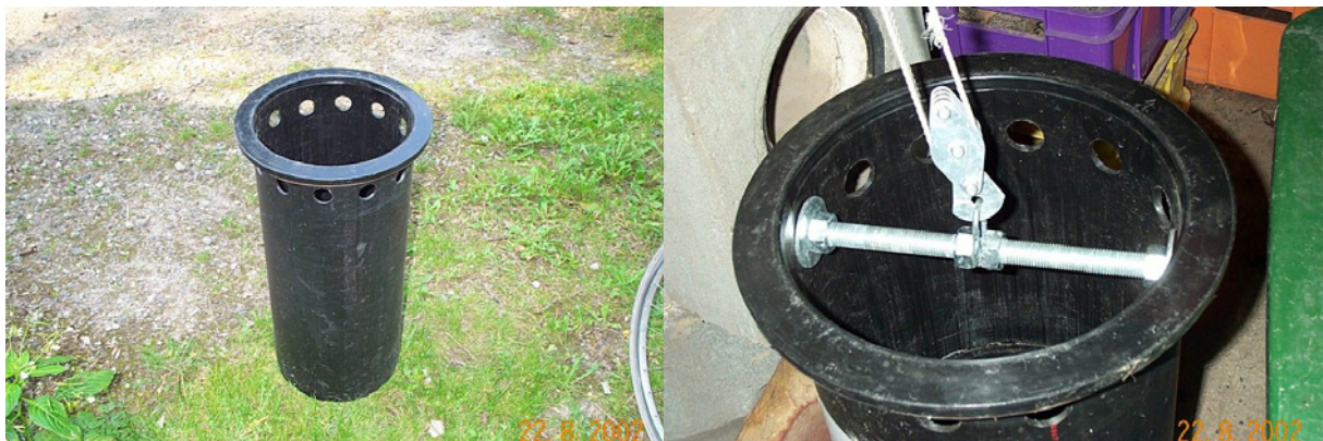
Abb. 60/Abb. 61: Filterpatrone mit Hebevorrichtung
