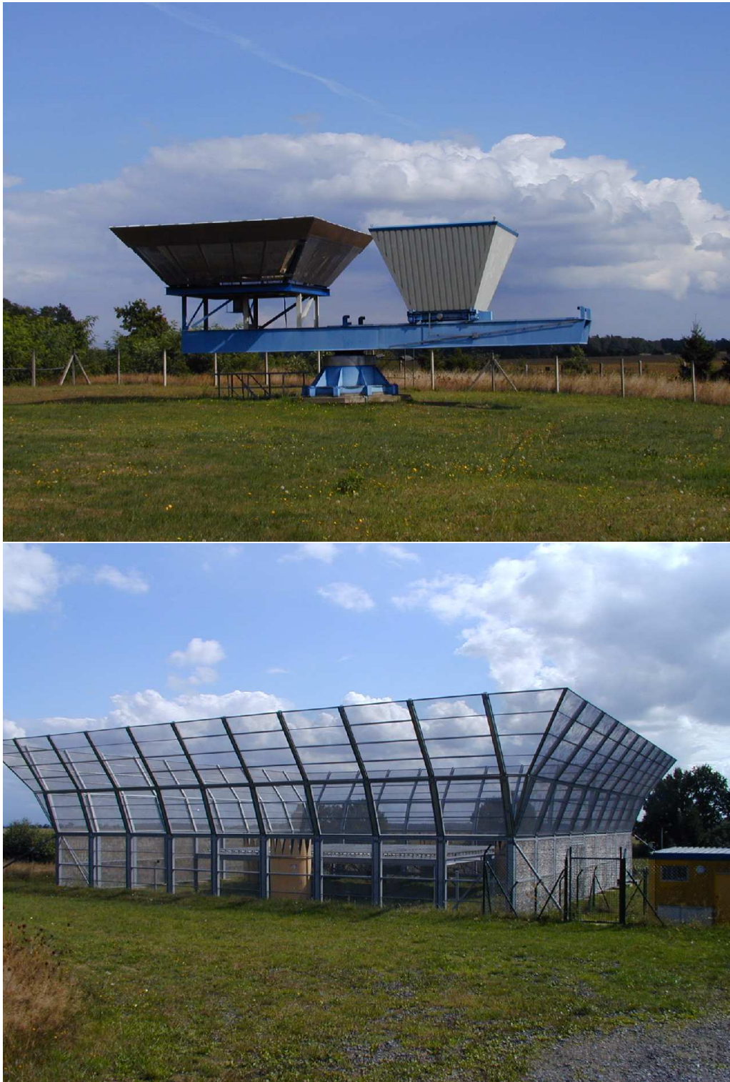
Abbildung 3.6.: Grenzschichtwindprofiler (LAP, oben) und Troposphärenwindprofiler/RASS (TWP, unten) am MOL. Das Antennenfeld ist beim TWP von einem Zaun zum Schutz vor Störeinflüssen umgeben.
