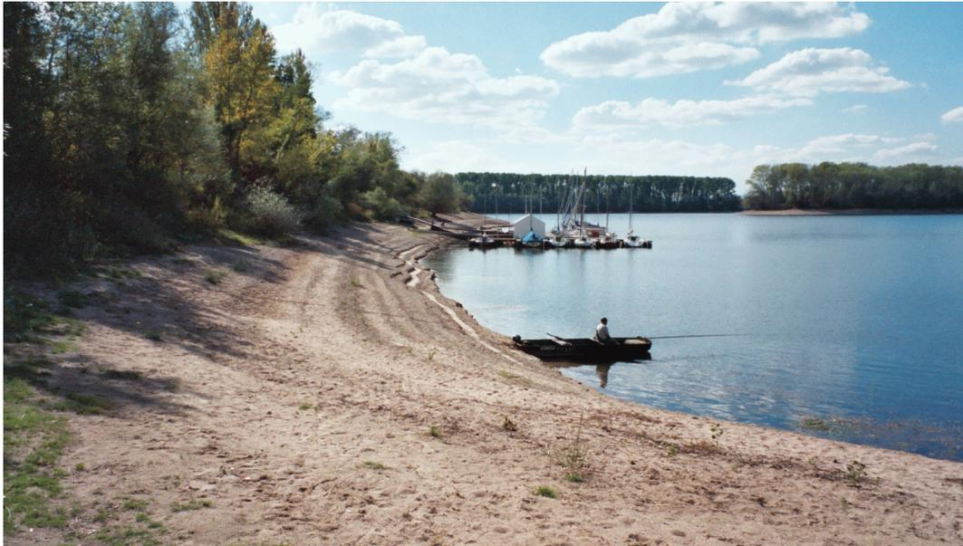
Abb. 37: Ausbildung der Wasserwechselzone im Kies mit einer Neigung von H:L ~ 1:5,00 an einem Baggersee in fluviatilen Ablagerungen des Jungpleistozän am Oberrhein (Aufschluss-Nr.: 28, Baden-Württemberg).
