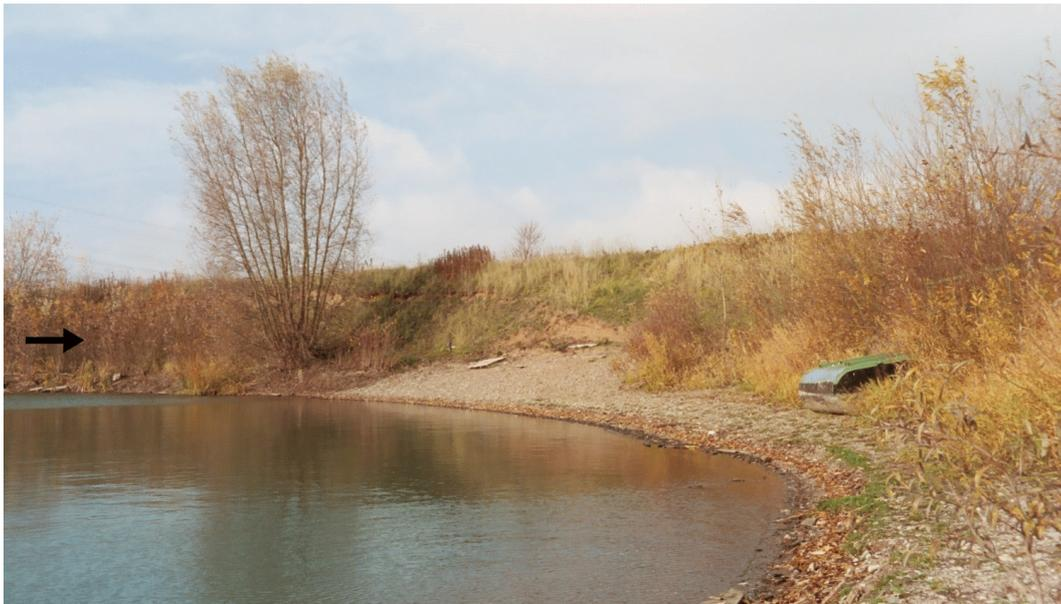
Abb. 6: Verlagerung der Uferlinie mit der Anlage von nicht standsicheren Abbruchböschungen in Richtung des Pfeiles auf benachbarte Grundstücke an einem Baggersee in fluviatilen Ablagerungen der Niederterrassen-Zeit an der Weser (*Aufschluss-Nr.: 25*, Niedersachsen).
