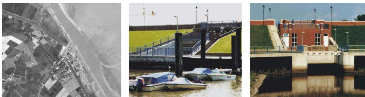
Abbildung 4-34: Informationen zu dem Siel bei Fedderwardersiel [3457320/5940780]: Luftbild [Quelle: SCOUT SYSTEMS] und Photographien
