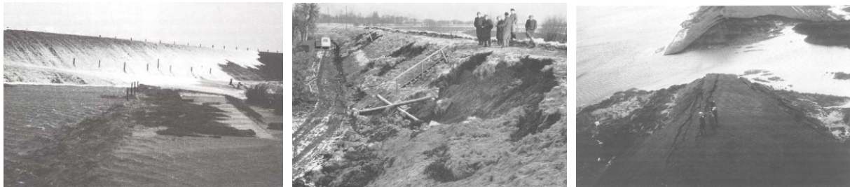
Abbildung 3-14: Erosion der Binnenböschung (mitte) und Deichbruch (rechts) infolge von Wellenüberlauf (links)
