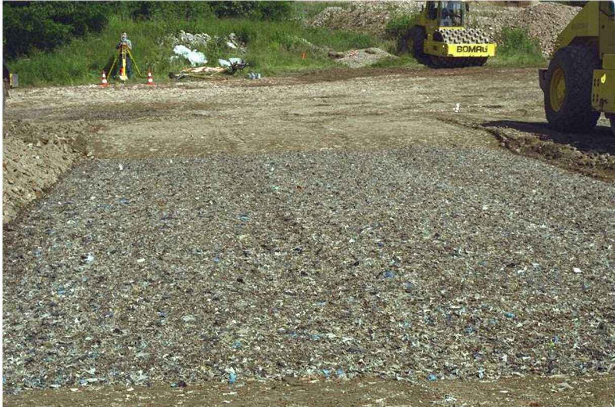
Bild 6-6: Verdichtete Lage, im Hintergrund Stampffußwalze
