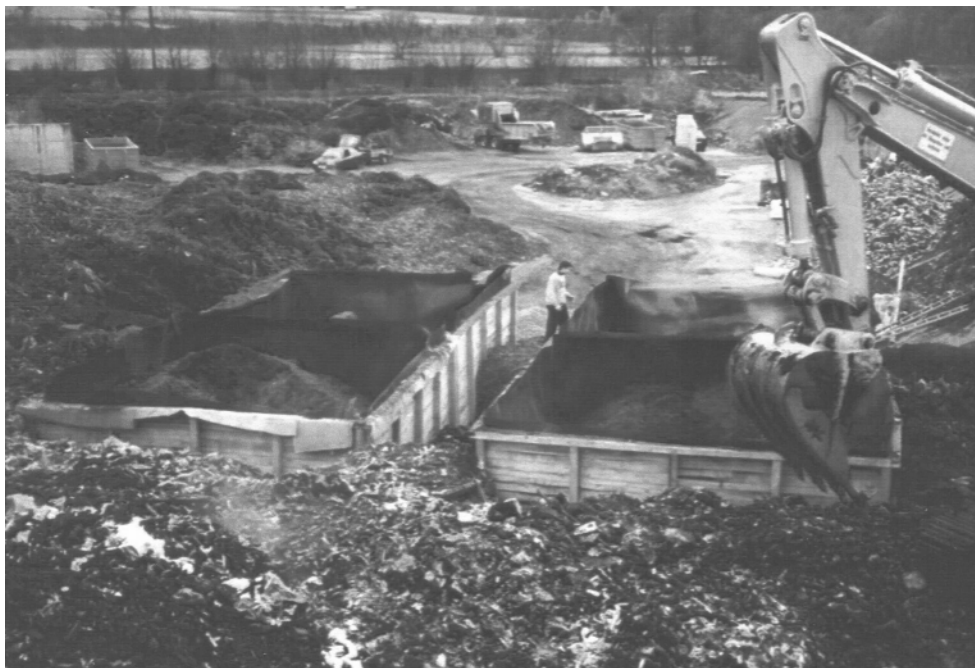
Bild 7-4: Befüllung und Einbettung der Testzellen Allerheiligen (Raninger et al., 2001)
