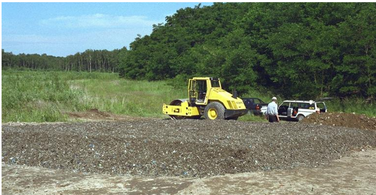
Bild 6-5: Glattmantelwalze und unverdichtete Lage (Feld 2)
