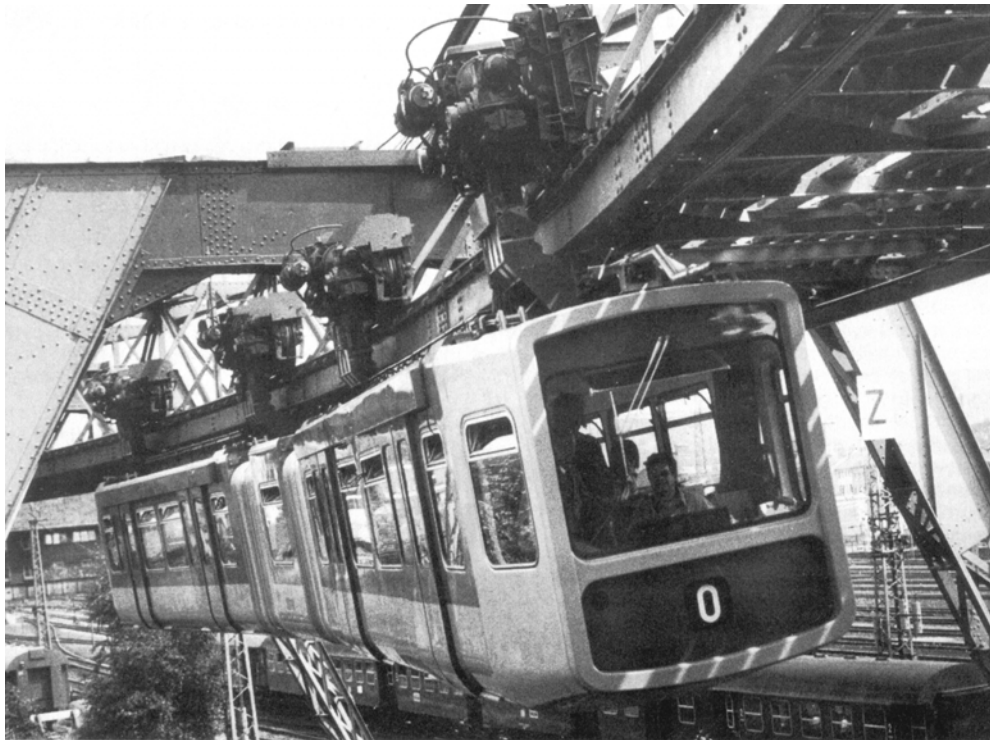
Abbildung 1: Die Wuppertaler Schwebebahn [2]
