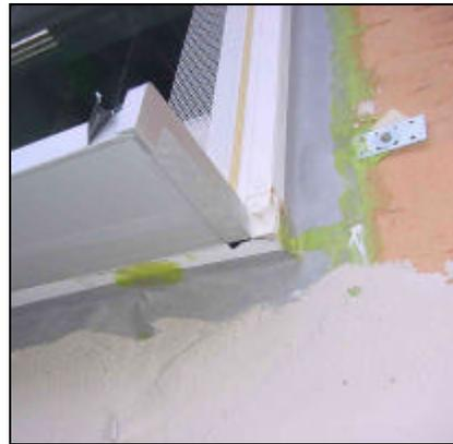
Bild 2.19 Zusätzliches Einputzen des Abdichtungsbandes
