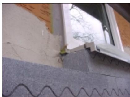
Abb. 3: WDV 20 cm dick – luftdichter Anschluss an das Fenster
