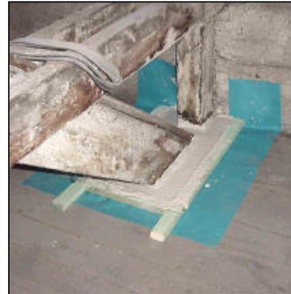
Bild 2.21 Sonderlösung zur Abdichtung von Durchdringungen: luftdichter Gipsverguss (Detaillösung: PHI Darmstadt)
