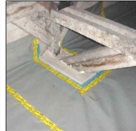
Bild 2.22 Verklebung des Gipsvergusses in die abdichtende Dampfbremse-Ebene
