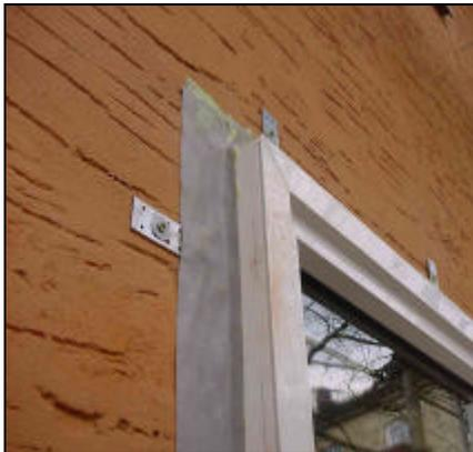
Bild 2.18 Luftdichte Verklebung des Fensters in der Kleberebene des Wärmdämmverbundsystems
