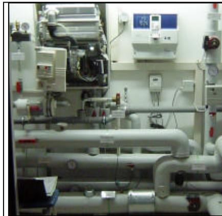
Bild 3.12 Heizraum mit vorbildlich gedämmten Heizleitungen
