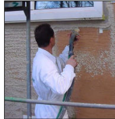
Bild 2.14 Luftdichtende Ebene im Kleberbereich des WDVS bei der Sanierung
