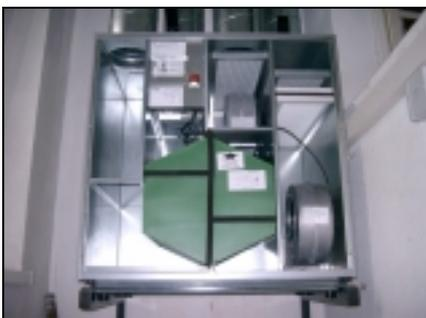
Abb. 9: Lüftungsgerät - Innenansicht
