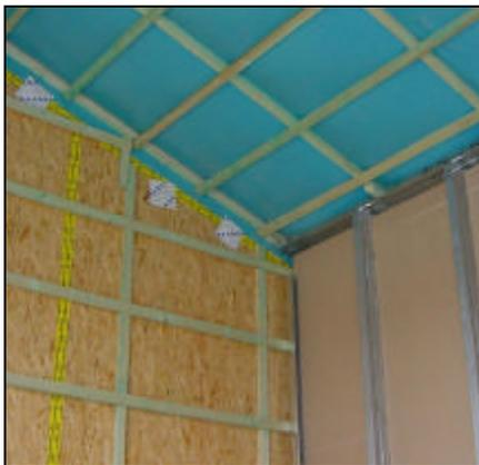
Bild 2.16 Anschluss von drei unterschiedlichen Ebenen im Holzbau
