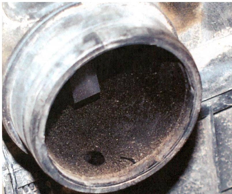
Abbildung 7.22: Reinluftseite hinter dem Motorluftfilter.
