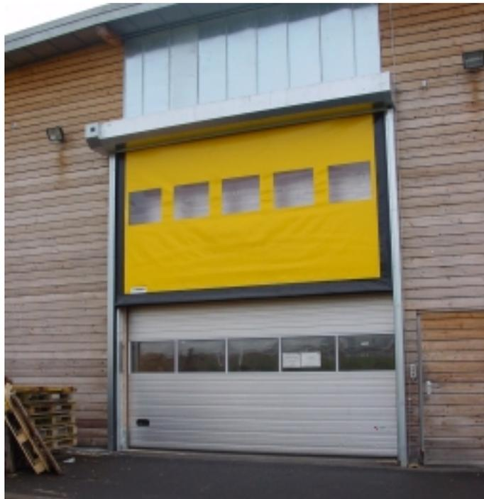
Abbildung 3.4: Nordosttor mit dem gelben zusätzlichen textilen Schnellauftor. Hinter dem halbgeöffneten textilen Schnellauftor ist das Sektionaltor zu erkennen
