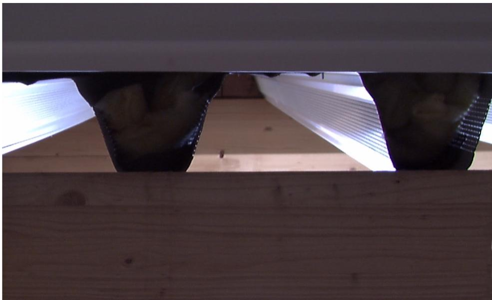
Abbildung 4.13: Blick in das Trapezblech an einem Shed. In den Flanken des Blechs sind die Lochungen für den Schallschutz und in den Sicken die Mineralwolle zu erkennen.
