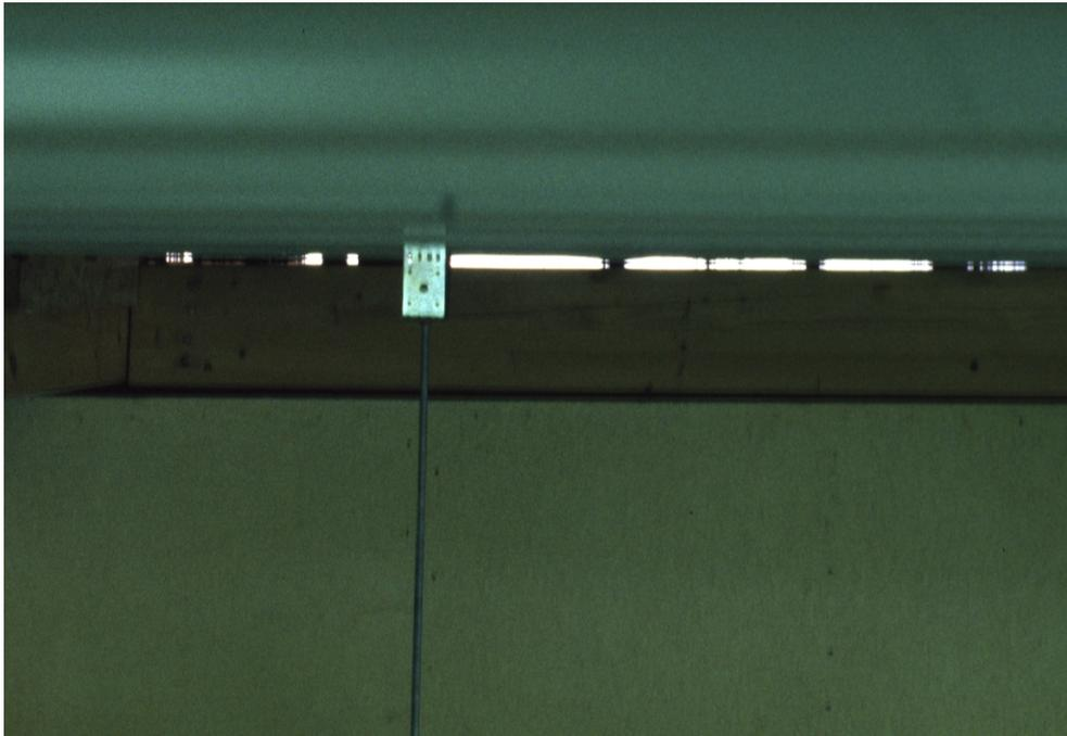
Abbildung 4.17: Spalt am Dach-Wand-Anschluss zwischen Trapezblech und Ringanker im Nordosten der Halle. Der helle Streifen ist von innen sichtbares Tageslicht
