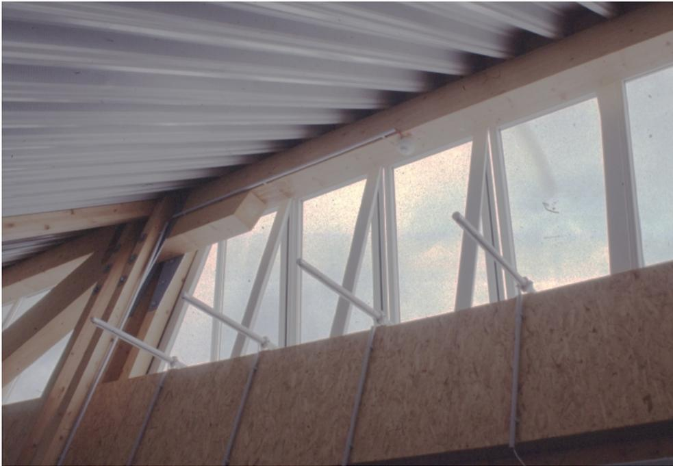
Abbildung 4.5: RWA-Klappen mit den Spindelmotoren zum Öffnen und Schließen der Klappen
