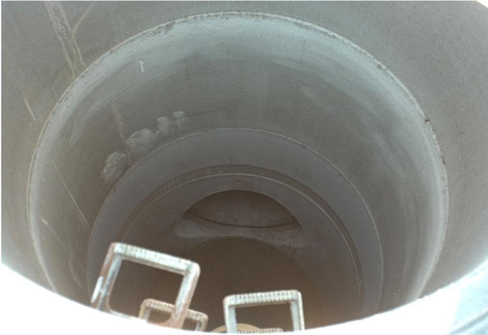
Abbildung 4.24: Blick in einen Luftbrunnen. In der Bildmitte ist der Anschluss des EWT zu erkennen.
