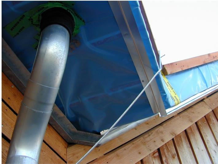
Abbildung 4.15: Nachträglich abgedichteter Dach–Wand–Anschluss. Die blaue Folie stellt den luftdichten Anschluß zwischen Außenwand und Dachfläche sicher
