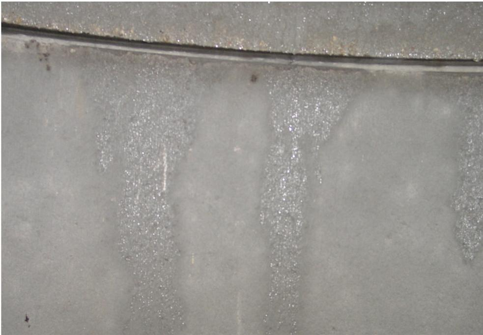
Abbildung 4.59: Kondensatbildung im östlichen Frischluftbrunnen bei sehr hoher relativer Außenluftfeuchte
