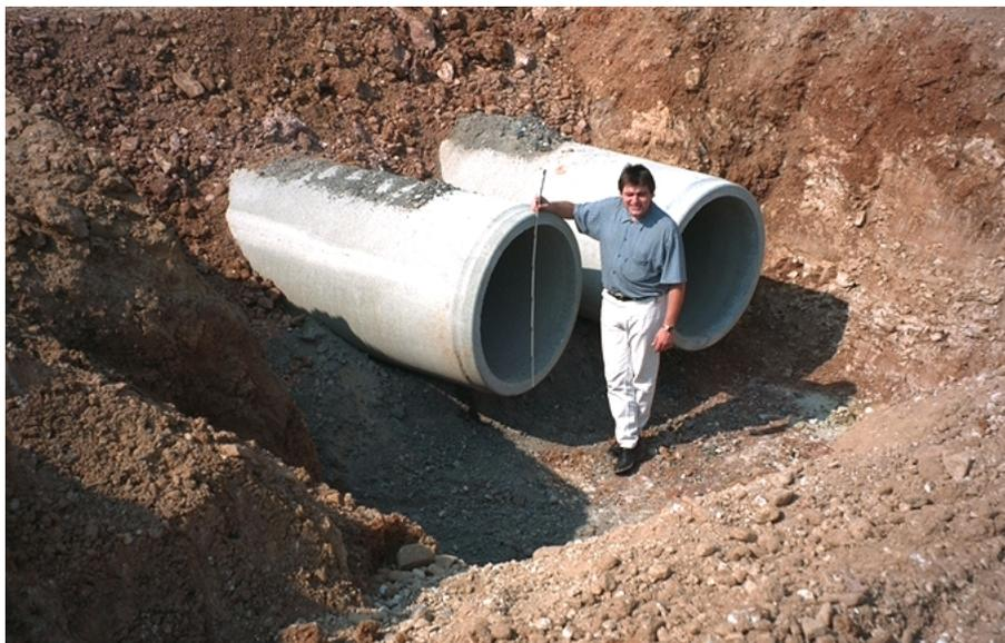
Abbildung 4.20: Rohre des EWT während der Verlegearbeiten
