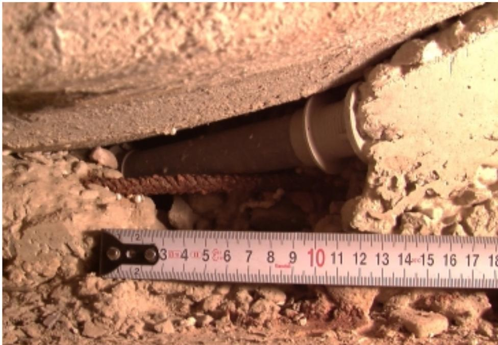
Abbildung 4.27: Betonmester unterhalb der einmündenden Rohre des EWT ermöglichten den Wassereinbruch. Das Bild zeigt die Wand des Zuluftsammelschachts unterhalb der einmündenden westlichen EWT.
