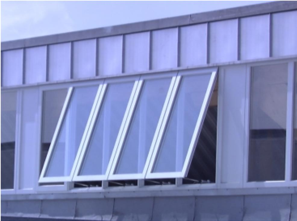
Abbildung 3.6: Nicht regensichere seitliche Öffnungsflächen der RWA-Klappen
