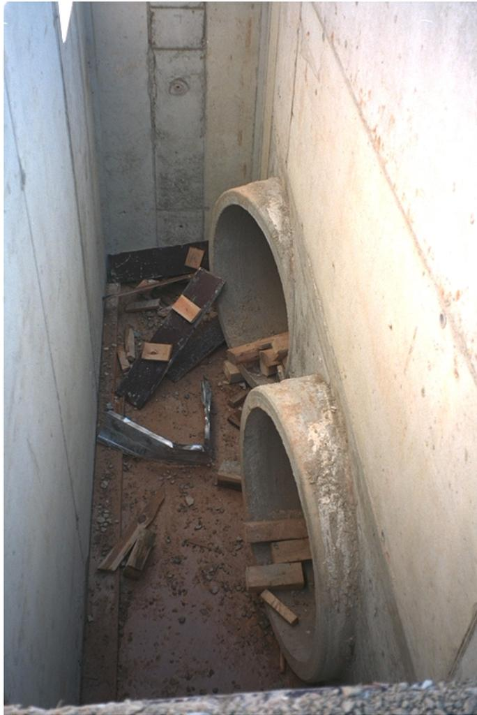
Abbildung 4.22: Blick in den Zuluftsammelschacht während der Bauphase. Rechts münden die Rohre des EWT in den Zuluftsammelschacht ein
