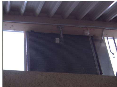
Abbildung 4.6: Der Abluftwärmetauscher im zweiten südwestlichen Shed der Halle
