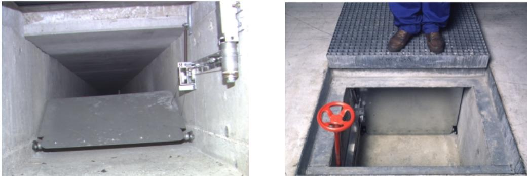
Abbildung 4.4: Einregulierung der Volumenströme an den Quellluftauslässen
