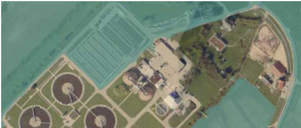
Abbildung 6.11: Der in Abbildung 6.9 als Klärwerk erkannte Bereich
