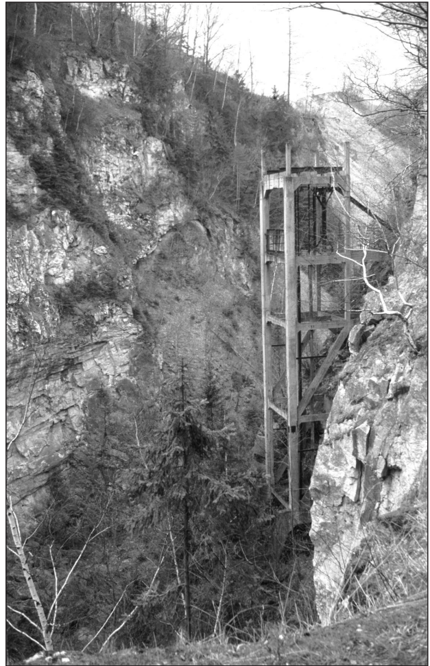
Abb. 3: Alter, stillgelegter Steinbruch „Todesbruch“ (N' Silesia), Turmhöhe etwa 50m. Der Kalzit-Marmor wurde dort unter schwierigsten bergmännischen Bedingungen im Tiefabbauverfahren gewonnen.
