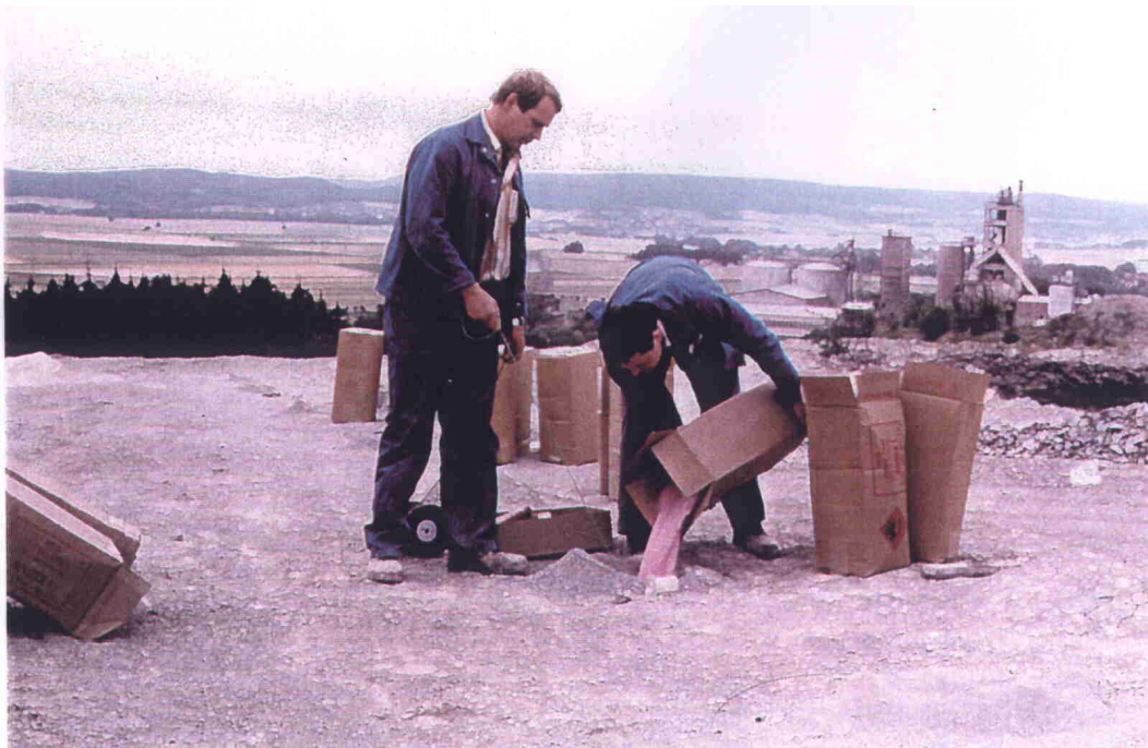
(Laden eines Bohrlochs mit losem Sprengstoff )
