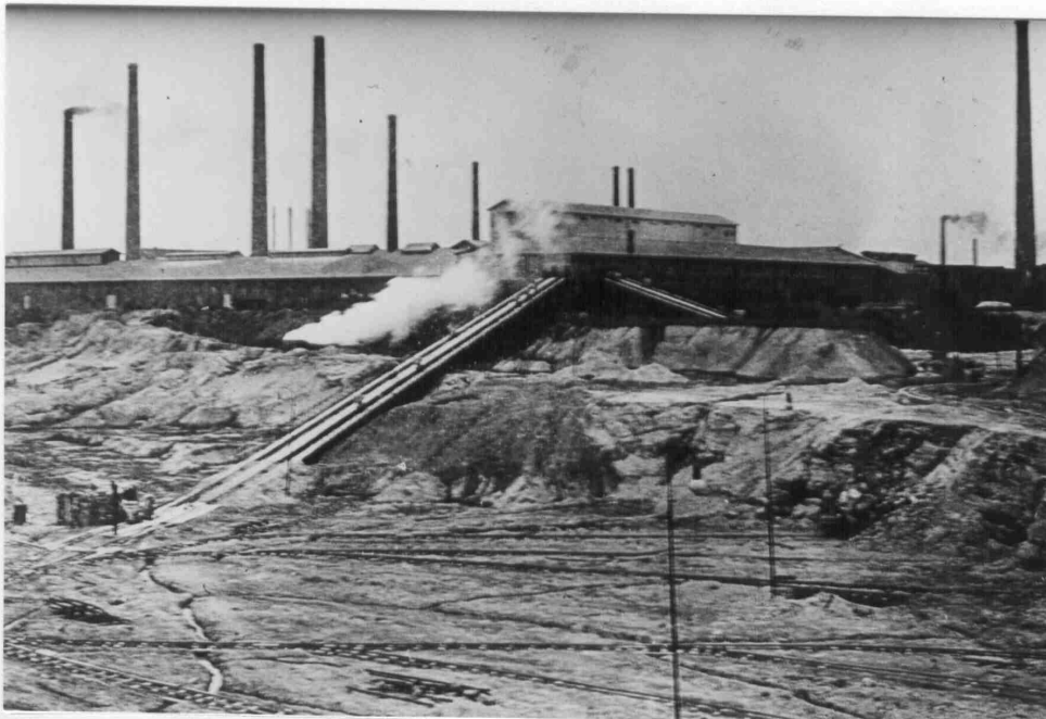
Bild 28: Schrägaufzug im Bruch der HPC
