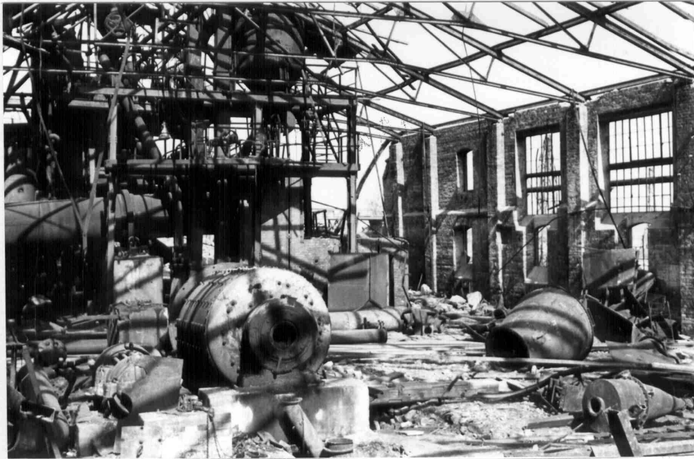
Bild 36: Zerstörte Maschinenanlage auf der HPC ( 1945 )
