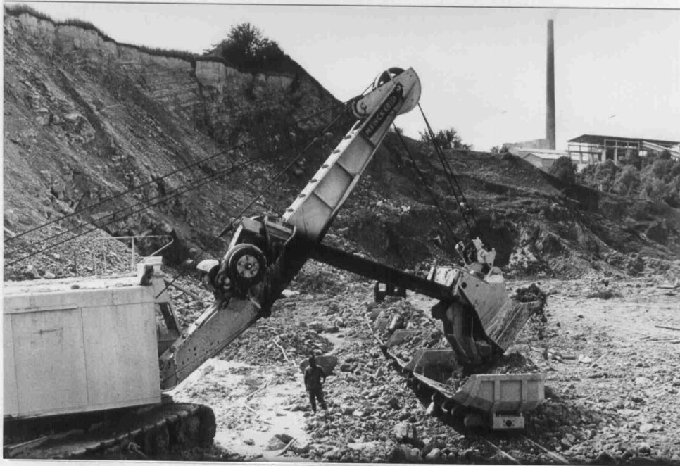
Bild 27: Bruchbetrieb der HPC – Lorenbeladung durch Elektrobagger( um 1955)
