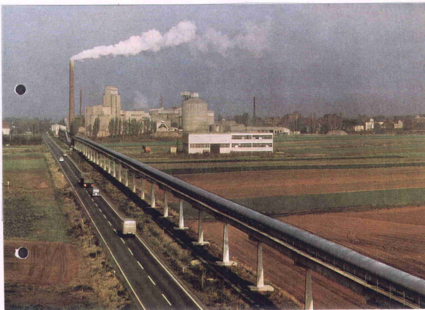
Bild 32: Rohmaterial-Transportband vom Steinbruch zum Werk in Wunstorf ( 1967 )
