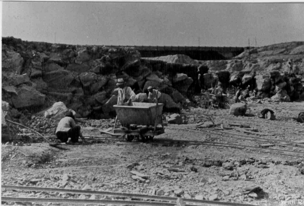
Bild 3: Arbeit im Steinbruch mit Kipploren
