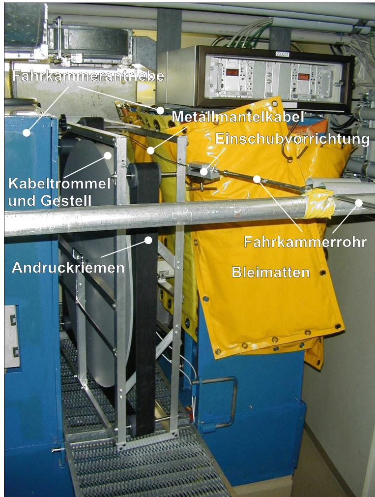
Bild 5.1: Aufbau für Beschleunigungsmessungen, CA-607 im Fahrkammersystem
