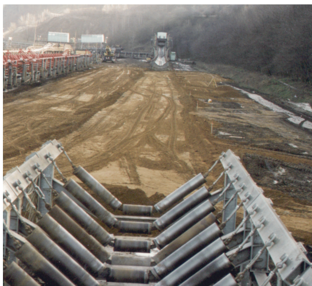
Bild 5.1: Planum im Bereich der Messstrecke
