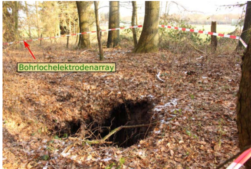
Abbildung 1.4.15: Junger Erdfall in Münsterdorf, entdeckt am 5. Februar 2019. Er hat eine Tiefe von ca. 6 m und einen Durchmesser von ungefähr 4 m (Foto: R. Kirsch).
