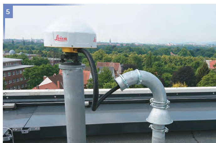
Abbildung 5 Neu installierte GNSS-Referenzstation am HiTEC auf dem Dach des Einstein-Elevators.
