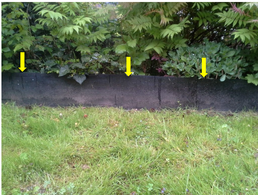
Abb. 26: Vertikale Barriere im Übergangsbereich zwischen Rasen und Beetfläche
