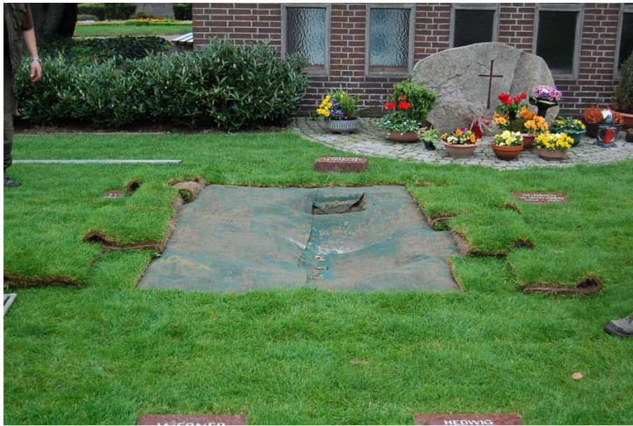
Abb. 29 b: Freilegen der Einbruchstelle, Aufnehmen des frisch verlegten Fertiggrasens (Verlegungszeitpunkt 6 Tage zuvor)
