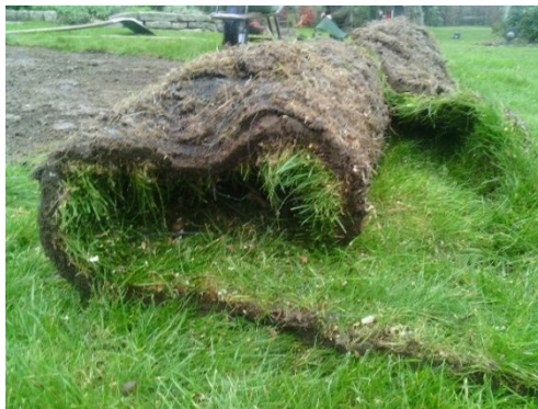
Abb. 90 a: Abstechen und Lösen der Rasennarbe oberhalb der Barriere
