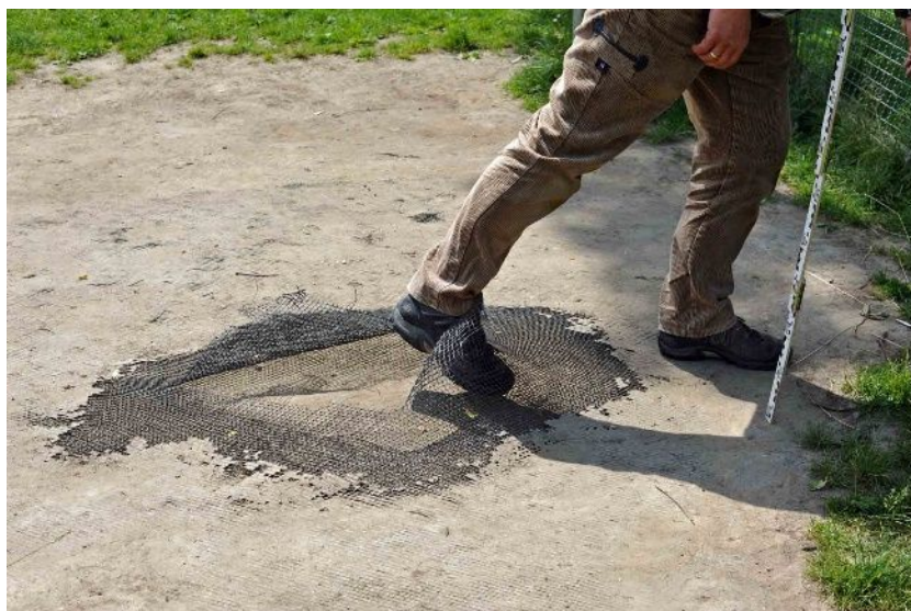
Abb. 67 c: Verletzungsgefahr durch freigespielte, horizontale Barriere im Torraum (Foto: Labenda, 2016)
