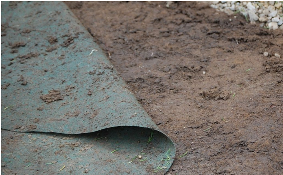
Abb. 32 c: Vom Untergrund gelöste horizontale Barriere
