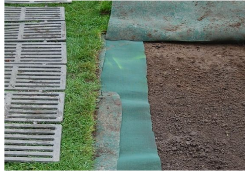
Abb. 90 d: Einlegen der Nahtbänder
