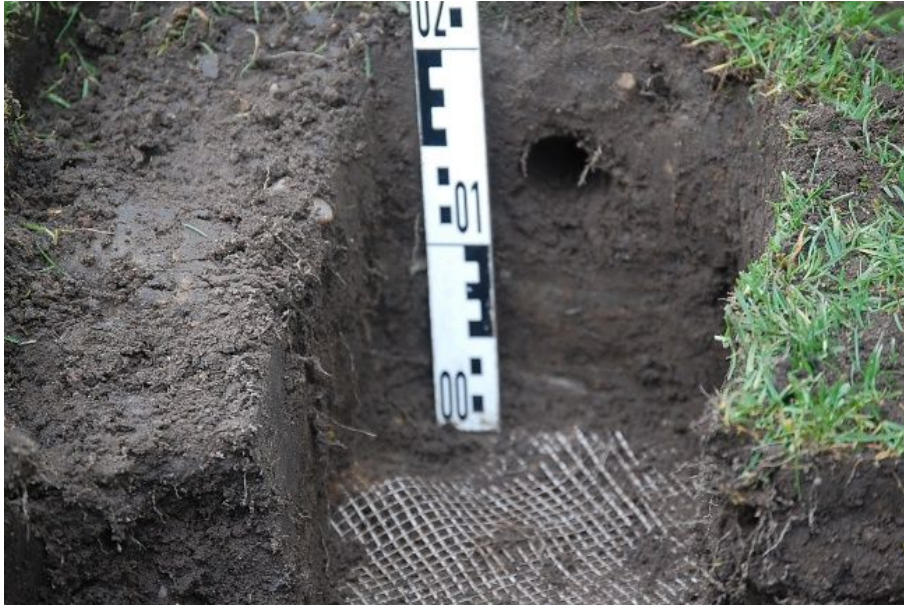
Abb. 60: Maulwurfsgang 11 cm über der Barriere, keine Barrierewirkung des Geotextils
