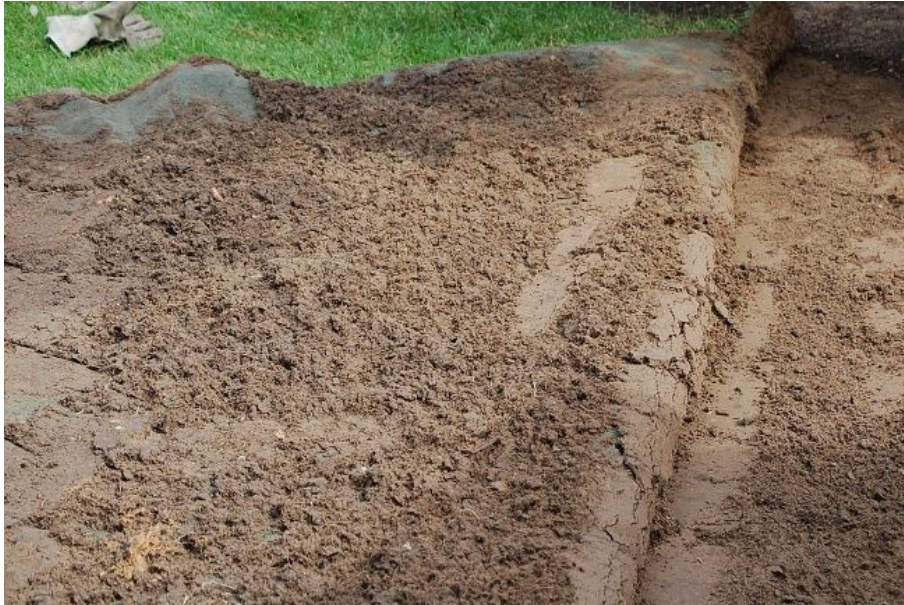
Abb. 44 a: Abgezogener Fertigrasen mit durchwurzelter horizontaler Barriere und anhaftendem, durchwurzeltem Boden
