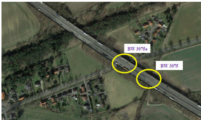
Abbildung 1: Übersicht Brückenbauwerke – Nord-Westlich Gemeinde Holle (Quelle: Google Earth)
