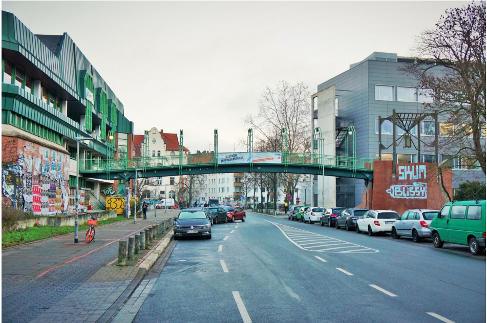
Abbildung 4: Brückenbauwerk des Feldversuches - die Mensa-Brücke an der LUH (Foto: von Gösseln).
