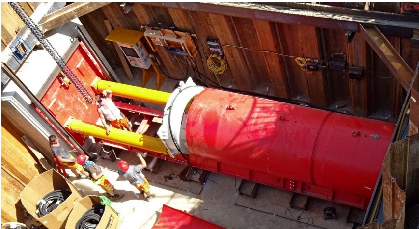
Abbildung 16: Startschacht des Pressvortriebs
