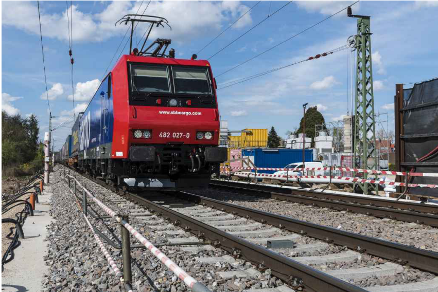
Abbildung 13: Tunnel Rastatt mit Amberg TrackControl
