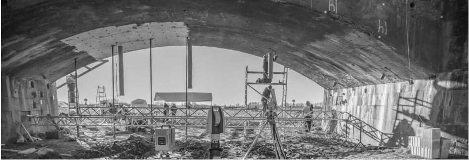
Abbildung 2: Blick in die historische Gewölbebrücke über die Aller bei Verden während der Installation der Messtechnik. Der geweitete Bereich an der Gewölbeunterseite kennzeichnet den Bereich im unmittelbaren Einfluss der Lasteinleitung, die durch die vier Hydraulikzylinder oberhalb und die senkrecht nach unten verlaufenden Gewindestangen und schlussendlich die Verpresspfähle realisiert ist. Im Vordergrund die geodätischen Sensoren des GIH (von links): Laserscanner Z+F Imager 5006, Lasertracker Leica AT960-LR und Präzisionstachymeter Leica TS30 (Paffenholz et al. 2018).
