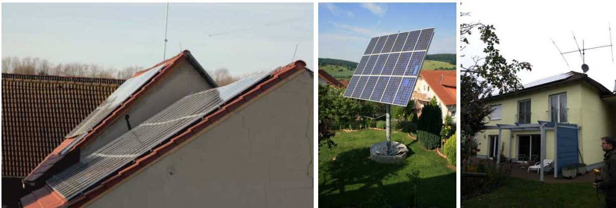
Bild 6: Untersuchte PV-Anlagen; Dachanlage auf Scheune, Solarbaum, Aufdachanlage an einem Einfamilienhaus
