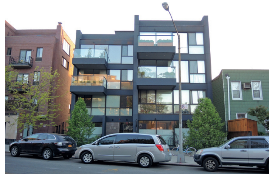
Abb. 3–30: Wohnungsneubauten in Brooklyn (Foto: E. Kruse, 2013)
