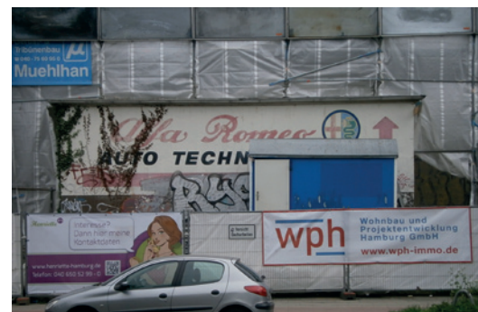
Abb. 6–24: Abriss von Gewerbeflächen zugunsten von Wohnneubauten im südlichen Eimsbüttel (Foto: S. Schreiner, 2013)
