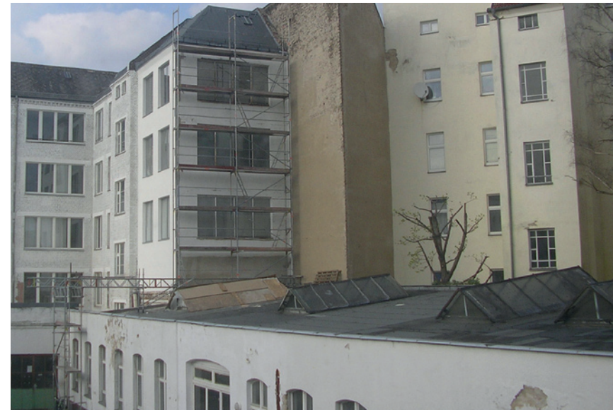
Abb. 3-24: Sanierung historischer Manufakturflächen (Foto: S. Schreiner, 2011)
