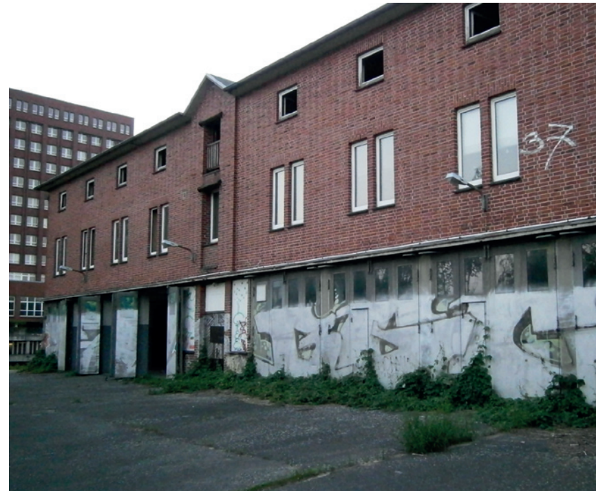
Abb 4–70: Ehemalige Verwaltungs- und Werkstattgebäude von Hamburg Wasser am Hochwasserbasin in Hammerbrook wurden zu „Clockwork“ (Foto: S. Schreiner, 2014)
