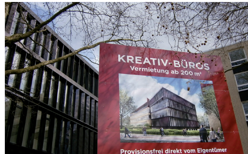
Abb. 4–67: Leerstand in Büroneubau im Gewerbegebiet Waterloohein (Foto: S. Schreiner, 2013)
