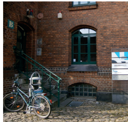
Abb. 4-57: Medien/IT-Firmen auf dem Gelände des ehemaligen Gaswerks (Foto: S. Schreiner, 2013)
