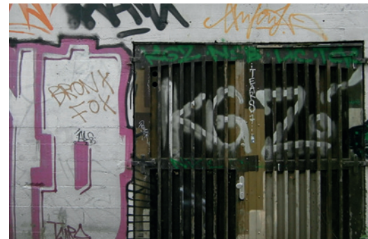
Abb. 6–9: Haupteingang des Bunkers am Weidenstieg (Foto: S. Schreiner, 2014)
