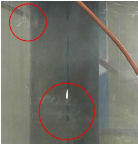
Abbildung 2.17: „Nebelschwaden“ infolge eines Partikeltransports, hervorgerufen durch Wasserströmungen in Rissen bei zyklischer Beanspruchung aus [45]
