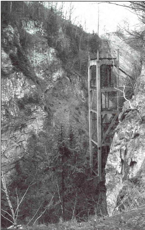
**Abb. 3** - Alter, stillgelegter Steinbruch „Todesbruch“ (N<sup>o</sup> Silesia), Turmhöhe etwa 50m. Der Kalzit-Marmor wurde dort unter schwierigsten bergmännischen Bedingungen im Tiefabbauverfahren gewonnen.
