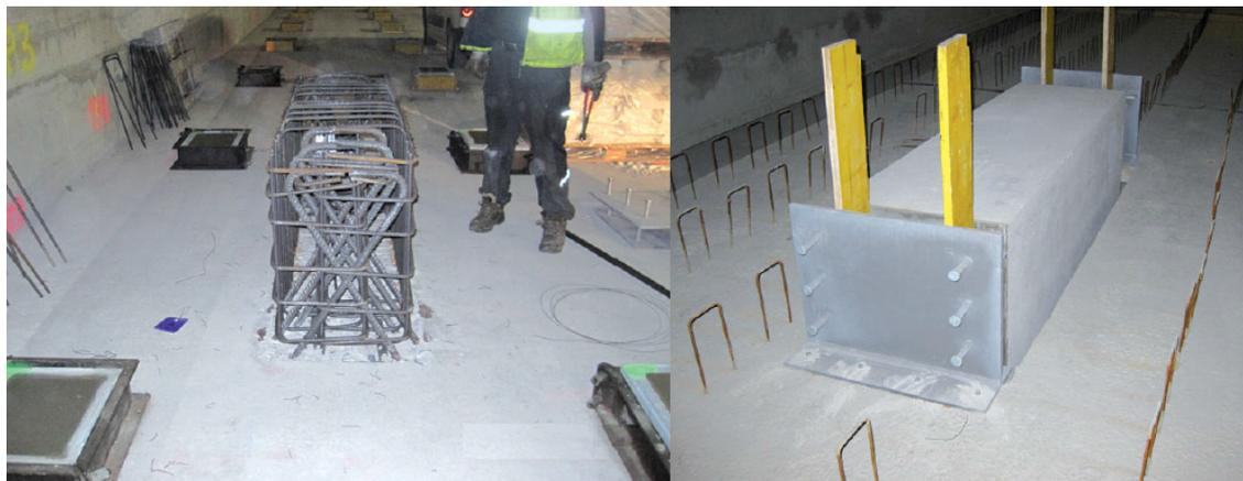
Abbildung 2.36: Bewehrte und in der Tunnelsohle verankerte Längsfesthaltung [Sai13]
